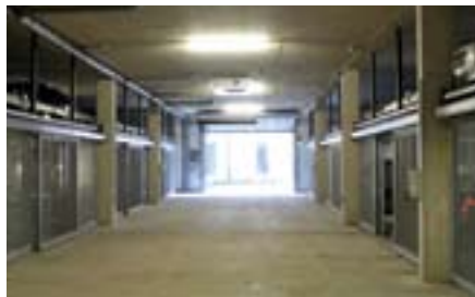
Porte di sicurezza installate a livello entrata per evitare pericoli di caduta o schiacciamento durante lo spostamento delle piattaforme.
