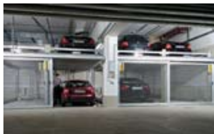
L'utente preleva l'auto dalla piattaforma e chiude la porta. Il sistema rimane in questa posizione fino alla prossima procedura di parcheggio.
