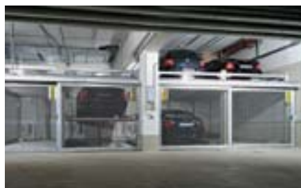
La piattaforma che occupava il livello di entrata sale al livello superiore e una volta raggiunta la posizione si blocca meccanicamente.
