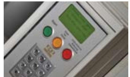
Pulsantiera di comando per selezionare il posto auto desiderato.
