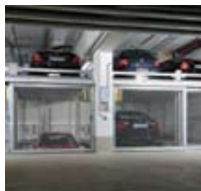
La piattaforma al piano inferiore sale al livello entrata nello spazio liberato.
