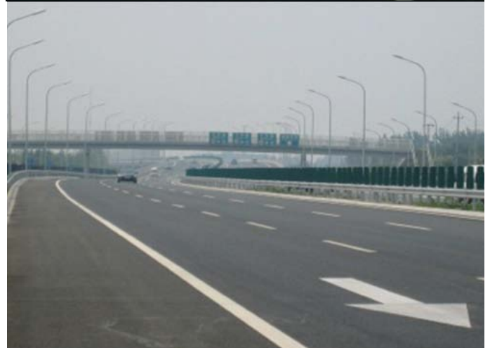
Autostrada per l'aeroporto di Pechino, Cina
