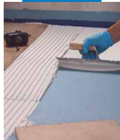
Incollaggio delle piastrelle su Mapelastic® AquaDefense
