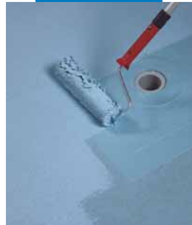
Applicazione a rullo della seconda mano di Mapelastic® AquaDefense
