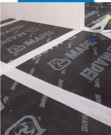
Una volta verificato il perfetto allineamento dei pannelli di Mapesilent Panel, chiudere accuratamente tutti i giunti tramite il nastro Mapesilent Tape
