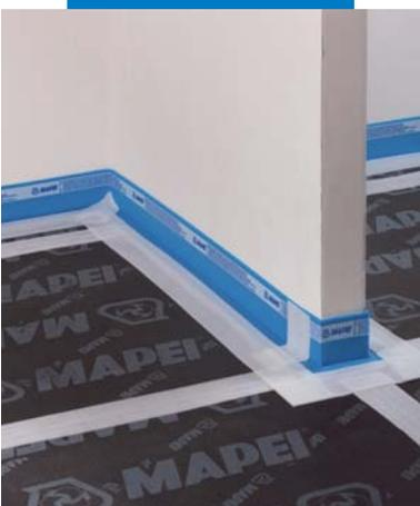
*Al termine del lavoro, il nastro Mapesilent Tape dovrà essere visibile su tutte le sovrapposizioni e giunzioni di Mapesilent Panel e di Mapesilent Band R (o Mapesilent Band). Per nessun motivo dovranno essere presenti punti passanti di contatto con il sottofondo che costituirebbero dei ponti acustici*
