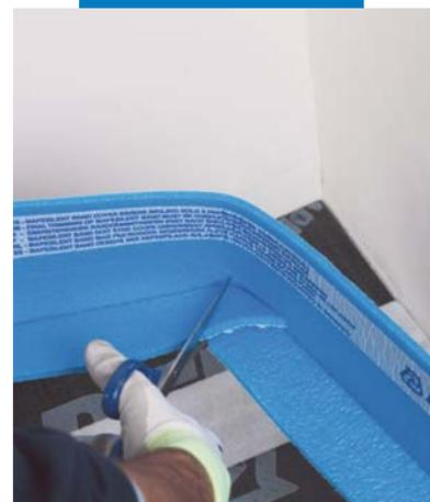
Tagliare **Mapesilent Band R** (o **Mapesilent Band**) nella parte inferiore, in modo da poter creare un angolo a 90° e rimuovere la pellicola protettiva nella parte retrostante al fine di scoprire la parte adesiva
