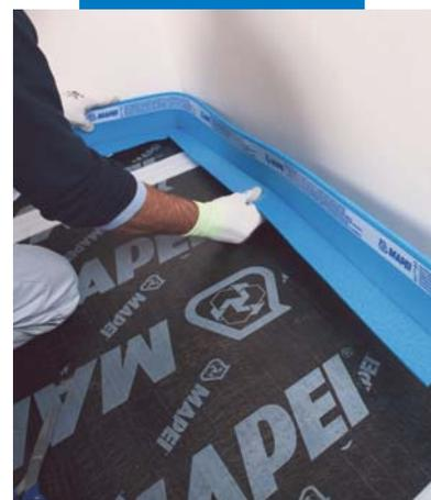
Posizionare l'angolo di **Mapesilent Band R** (o **Mapesilent Band**) in modo da verificare che le due parti del taglio combacino perfettamente
