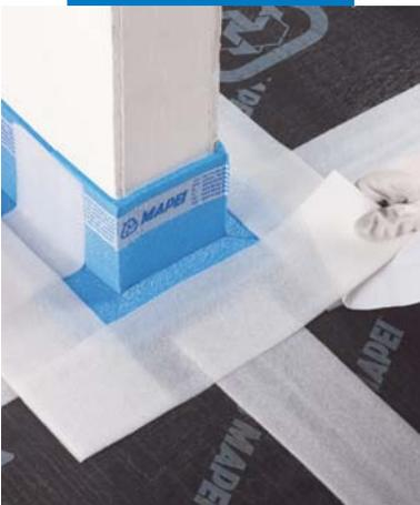
*Applicare Mapesilent Tape sulle sovrapposizioni tra Mapesilent Panel e Mapesilent Band R (o Mapesilent Band) e sulle giunzioni tra le varie fasce di Mapesilent Band R (o i profili di Mapesilent Band)*
