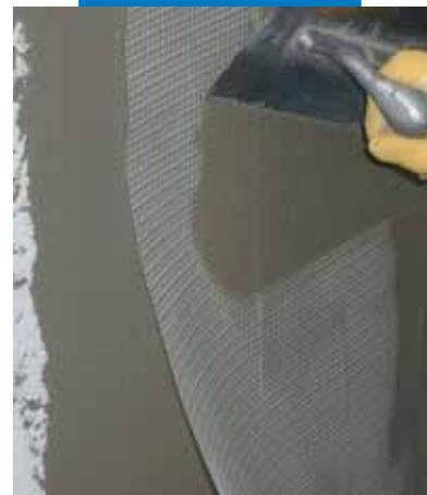
Rasatura dei pannelli termoisolanti armata con Rete in Fibra di Vetro annegata nello strato di Mapetherm AR1
