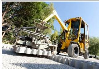
Per massimizzare la produttività in cantiere, si consiglia di adottare un sistema di posa di tipo "meccanico".
