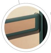
Il corrimano paracolpi 855 è provvisto di un inserto coestruso che moltiplica le possibilità di combinazione dei colori. Anche porte e telai sono soggetti a urti e stress da parte di carichi mobili. Una valida protezione con lastre Sanparrell ne allungherà il ciclo d'uso. Con lo stesso materiale, termoformato, è possibile rivestire i telai.
