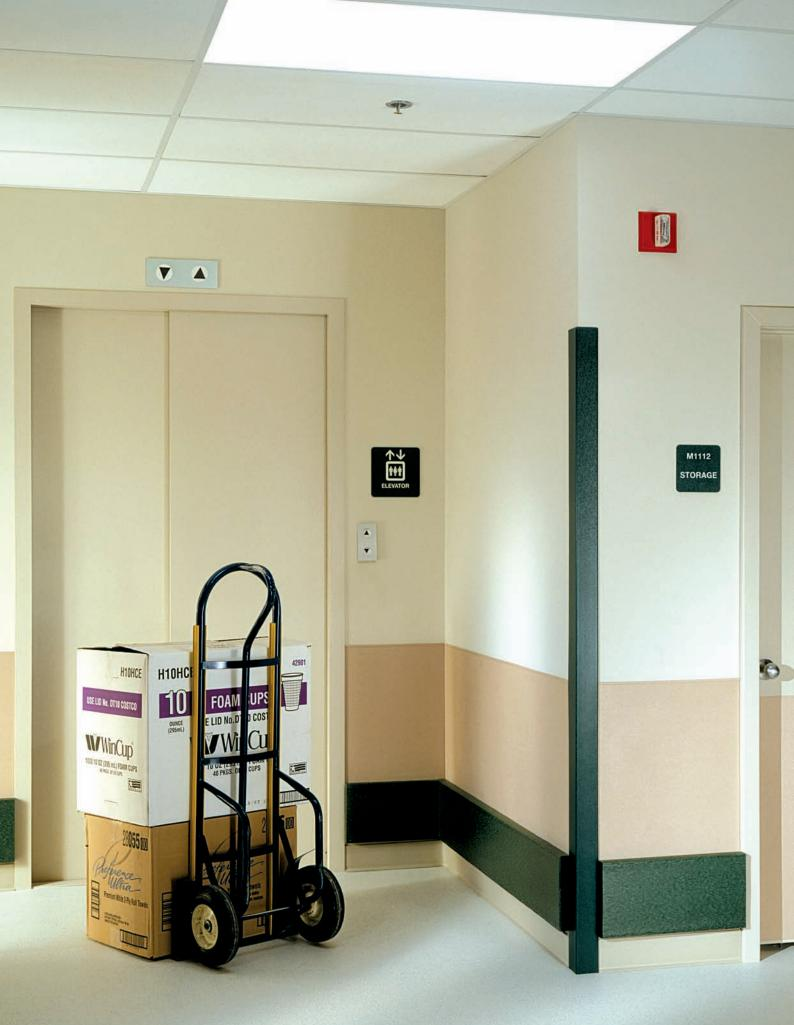
È un ambiente commerciale soggetto a carichi pesanti. Lastre di protezione della parete, paraurti, paraspigoli, protezioni di base garantiscono le pareti dagli urti a diversi livelli di altezza ed eliminano la necessità di continua manutenzione.
