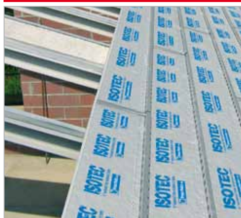
Posa di Isotec su struttura discontinua in ferro.
