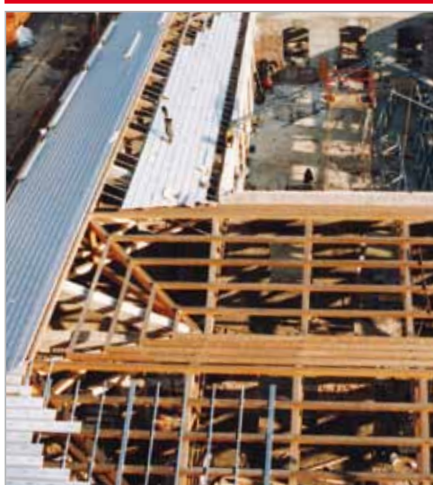
Posa di Isotec su struttura discontinua in legno/ferro.
