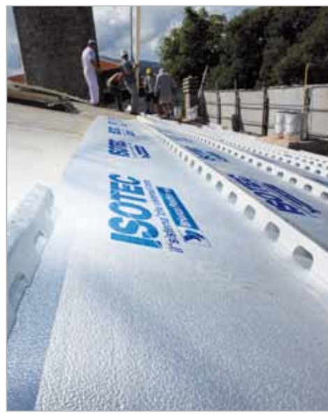
Posa di Isotec su struttura continua in laterocemento.
