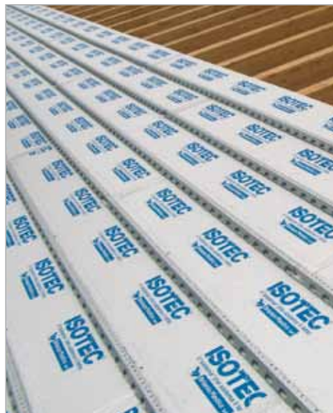
Posa di Isotec su struttura discontinua in legno.
