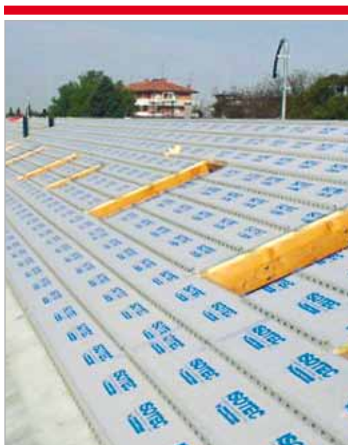
Posa di Isotec su struttura continua in laterocemento.
