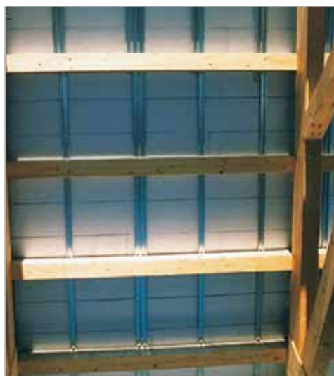
Posa di Isotec su struttura discontinua in legno/ferro.
