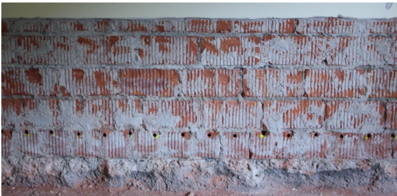
Muratura pronta per la ricezione del trattamento Antisale.
