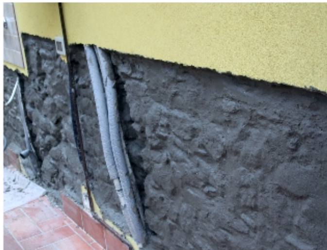
Muratura rivestita con Antisale.
