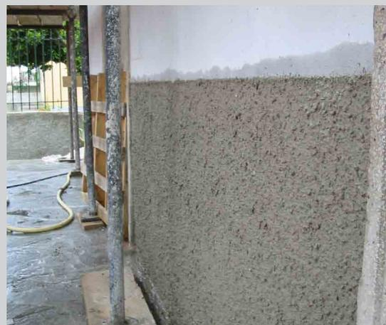
consistenza. In questo modo si mantiene lavorabile per almeno 60 minuti in condizioni normali (20 °C); nel caso di temperature più elevate il tempo di lavorabilità si accorcia. Applicare l'impasto così ottenuto manualmente con la cazzuola in uno spessore di almeno 2 cm; staggiare e frattazzare evitando lisciature troppo fini per non chiudere i pori superficiali dell'intonaco.
