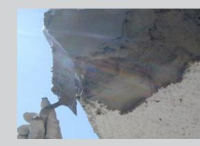
con cazzuola o spatola americana, oppure a spruzzo con idonea intonacatrice (per la rapidità della presa occorre sempre pulire le tubazioni e la lancia dell'intonacatrice ogni volta che si prevede una pausa nell'esecuzione dei lavori, onde evitare intasamenti difficilmente rimuovibili).
