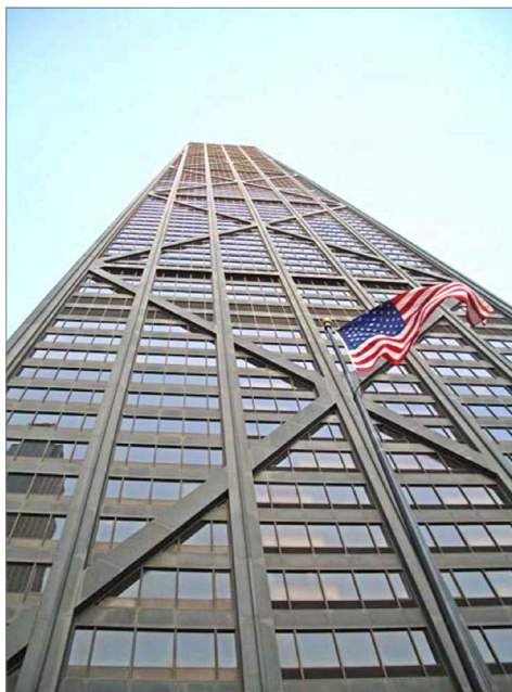
Figura 1.2. Controventi valorizzati come motivo estetico nella John Hancock Tower di Chicago (da Wikipedia, foto di “Akadavid”, 2008)
