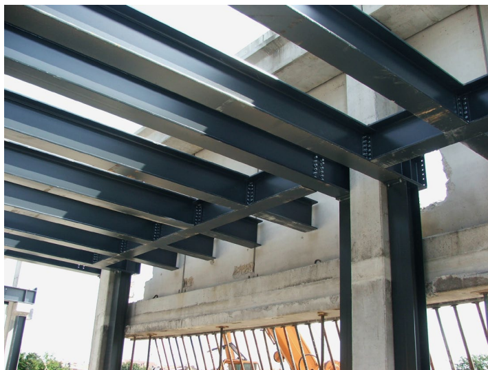
Figura 2.16. Trasmissione indiretta del carico
