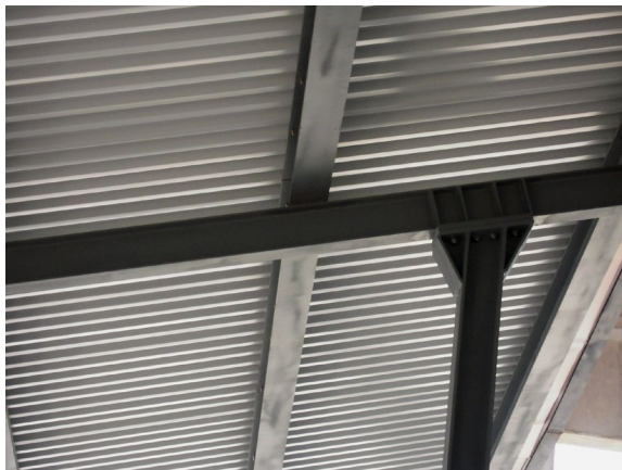
Figura 2.15. Trasmissione diretta del carico
