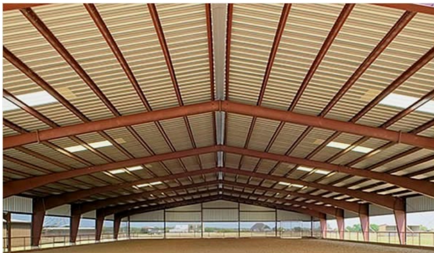
Figura 2.12. Travi principali e arcarecci
