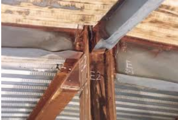
Figura 2.18. Instabilità in compressione
