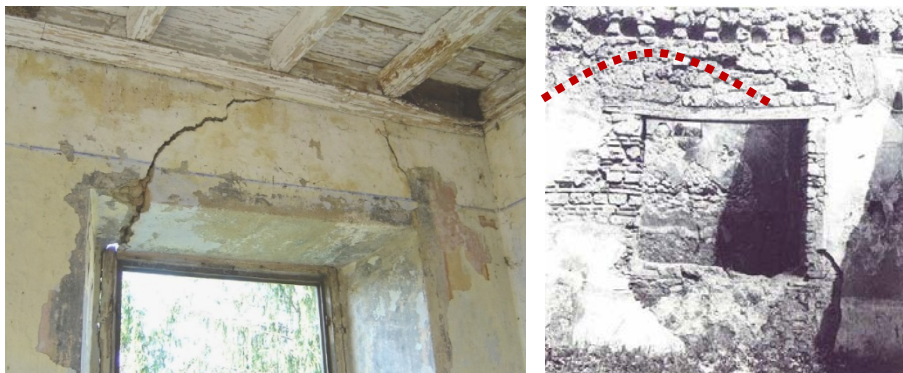
Fig. 040. Esempi di arco naturale al di sopra di un'apertura nella struttura muraria
