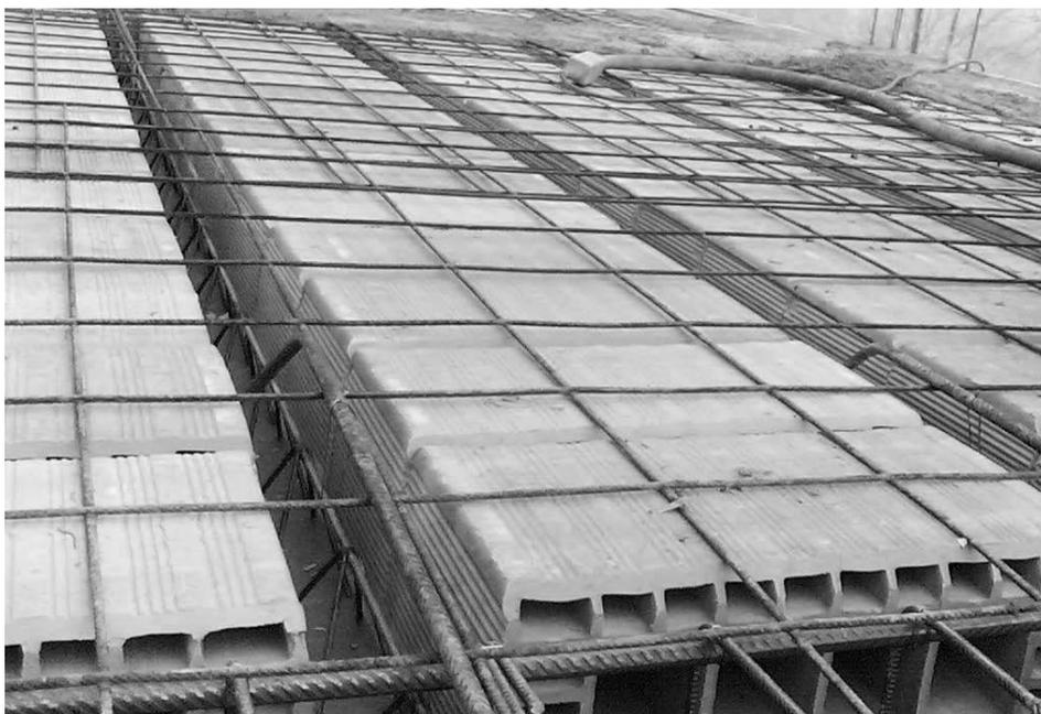
**Figura 3.1.** *Assemblaggio in opera di solaio in laterocemento*
