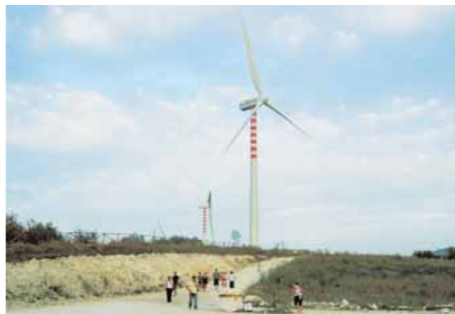
Fig. 34. La percezione sociale: l'immagine mostra un impianto eolico di recente costruzione a Durazzano (BN) sulla dorsale del monte Longano a 579 m di altezza. Si tratta di sette aerogeneratori di 67 m di altezza, con rotore di diametro pari a 83 m e pale di circa 40,5 m di lunghezza. La percezione sociale dell'impianto è cambiata con il passare del tempo: le polemiche sono state attutate dalla creazione di nuovi posti di lavoro e dal sorgere di una nuova attrattiva turistica. L'installazione delle macchine nel punto più alto del territorio ha portato alla creazione di un nuovo percorso panoramico da cui, spinti anche dalla curiosità per l'impianto, è possibile godere del paesaggio circostante.
