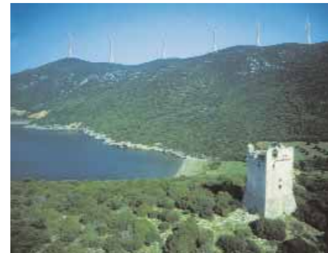
Figg. 47-48. Lo studio del colore e della disposizione delle macchine: in queste simulazioni vengono messe a confronto due soluzioni diverse per collocazione e colorazione dell'impianto. La soluzione a cavallo del crinale risulta più gradevole in relazione ai caratteri morfologici, storici e naturali del sito che ne fanno un luogo attrattivo e ricco di potenzialità fruibili. In ambedue le soluzioni, tuttavia, tali caratteri sono compromessi.
