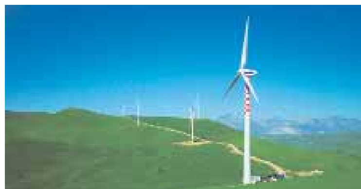
Figg. 22-23. I colori: le norme aeronautiche richiedono per le macchine di un impianto eolico la garanzia di un'adeguata visibilità. Da ciò deriva, ad esempio, l'uso di strisce di colore rosso per le estremità dei piloni, anche se esso può essere limitato alle macchine che segnano l'inizio e la fine dell'impianto o comunque a quelle poste nei punti più alti. Esso può essere sostituito da emissioni luminose al vertice dei piloni. Sono possibili alcune variazioni del tono del bianco al fine di ridurre la brillantezza e di armonizzare le macchine con il contesto in cui si inseriscono. Le indicazioni belghe suggeriscono, in ambito agricolo, di adottare una colorazione che vira al verde verso la base della macchina eolica al fine di garantire continuità con la linea di orizzonte.
