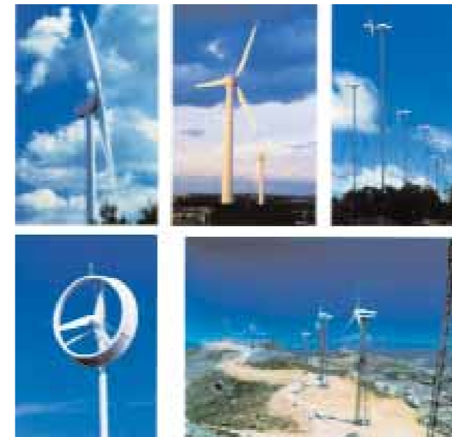
Fig. 16. Diversi tipi di strutture eoliche: le macchine eoliche hanno specifiche dimensioni dettate dalla necessità di dare solidità alla struttura e dalle loro funzioni; esse, perciò, possono essere difficilmente modificate. Anche il disegno delle pale è pressoché determinato. Esistono comunque diversi modelli di macchine: alcune hanno struttura trilitica, altre struttura tubolare, alcune sono bipale, altre tripale, alcune hanno asse orizzontale, altre asse verticale. Il modello più diffuso (per esempio in Francia e in Italia) è costituito da macchine a tre pale ed asse orizzontale. Sebbene le caratteristiche tecniche impongano notevoli restrizioni la progettazione delle macchine ha già consentito di arrivare a forme più gradevoli e meno dure.
