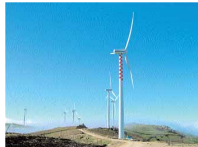
Fig. 24. Effetto visivo di una disposizione in linea: la letteratura sia italiana che estera concorda nell'attribuire un minore impatto visivo alla disposizione lineare degli aerogeneratori. Naturalmente sarà solo l'accurata conoscenza del luogo di installazione a suggerire la scelta progettuale più opportuna in relazione all'impatto visivo e alle sue conseguenze sui valori storici e simbolici del luogo.
