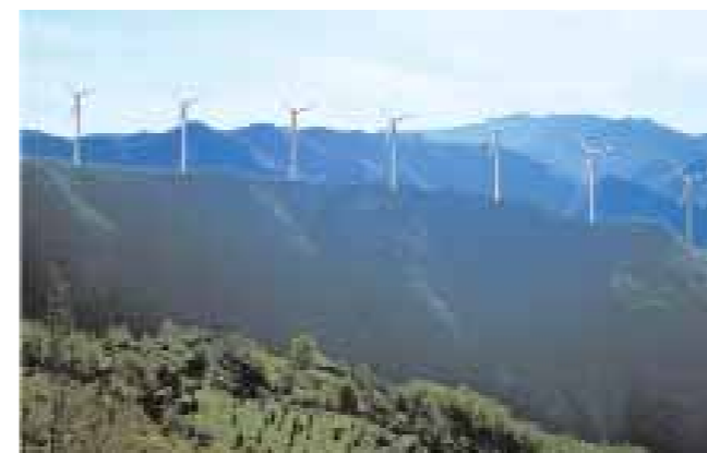
Fig. 26. Effetto visivo della disposizione lineare lungo la linea di crinale e della disposizione a quinconce a cavallo del crinale: le regole generali da adottare nella scelta della configurazione di un impianto eolico devono essere quelle di ridurre gli impatti negativi attraverso appropriati schemi di impianto. Spesso sui crinali delle montagne e lungo le linee di costa si prevedono allineamenti lineari ma anche disegni a quinconce, o schemi raggruppati in cluster. Sulle linee di crinale i generatori possono essere posti ai lati della linea di crinale con un impatto visivo ridotto, visto che parte dello sviluppo in altezza sarà coperto dal fianco della montagna. Quest'ultima soluzione è, dunque, da preferire soprattutto in relazione a paesaggi la cui capacità di assorbire nuove trasformazioni è ridotta.
