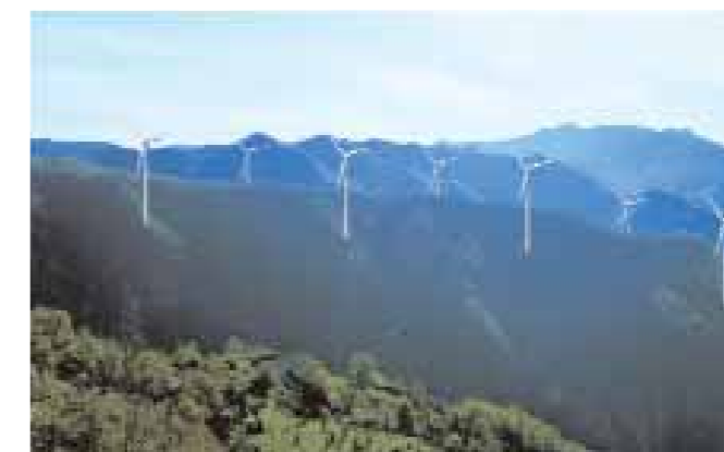
Fig. 26. Effetto visivo della disposizione lineare lungo la linea di crinale e della disposizione a quinconce a cavallo del crinale: le regole generali da adottare nella scelta della configurazione di un impianto eolico devono essere quelle di ridurre gli impatti negativi attraverso appropriati schemi di impianto. Spesso sui crinali delle montagne e lungo le linee di costa si prevedono allineamenti lineari ma anche disegni a quinconce, o schemi raggruppati in cluster. Sulle linee di crinale i generatori possono essere posti ai lati della linea di crinale con un impatto visivo ridotto, visto che parte dello sviluppo in altezza sarà coperto dal fianco della montagna. Quest'ultima soluzione è, dunque, da preferire soprattutto in relazione a paesaggi la cui capacità di assorbire nuove trasformazioni è ridotta.
