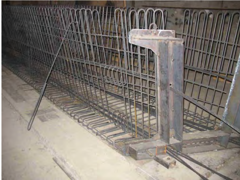
Figura 6.3 - L'armatura lenta di un tegolo in c.a.p.
