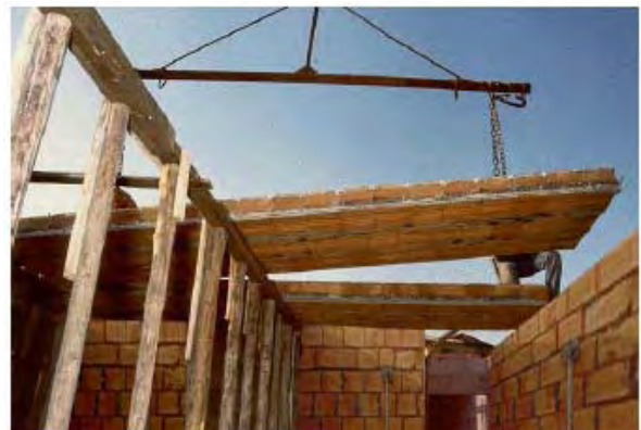
Figura 10.14 – Varo di solaio a pannelli prefabbricati
