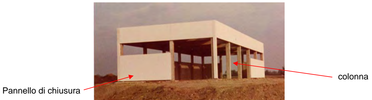
Figura 8.4 – Edificio prefabbricato in c.a.: vista esterna
