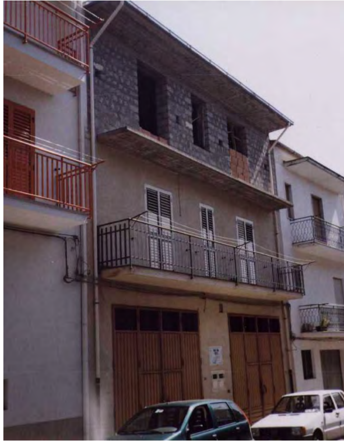
Figura 7.2 - Esempio di fabbricato sopraelevato
