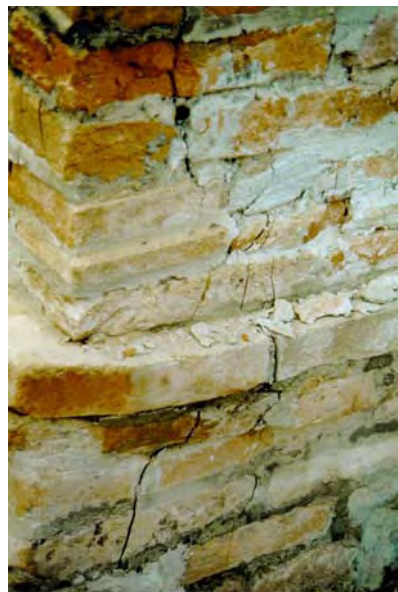
Figura 2.11 Muratura di mattoni pieni
