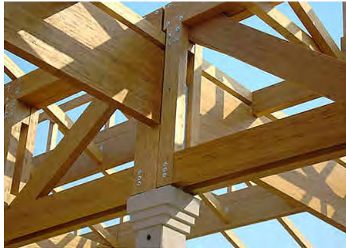
Figura 2.7 Travi in legno lamellare
