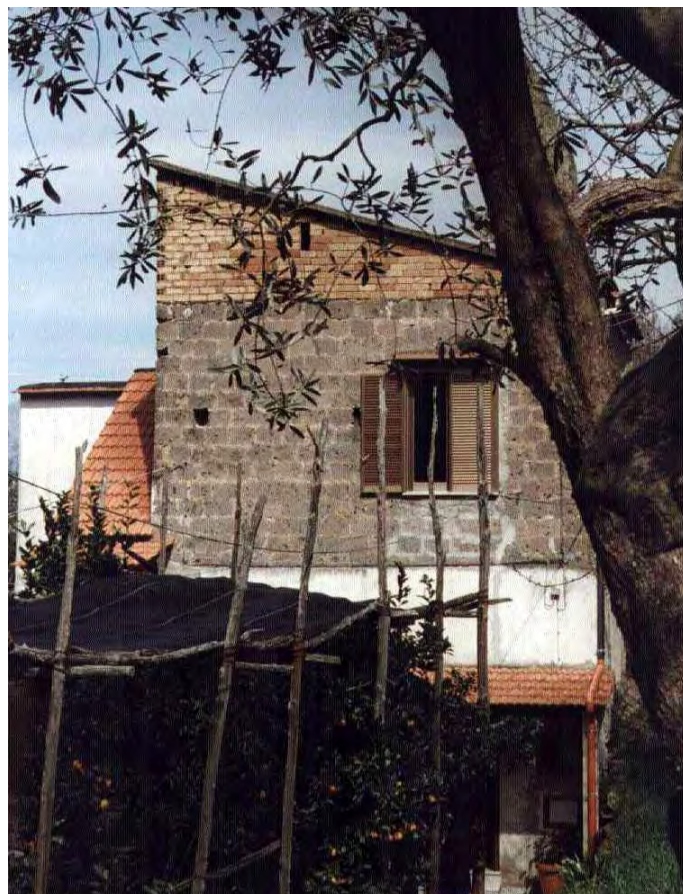
Figura 7.1 - Esempio di fabbricato sopraelevato
