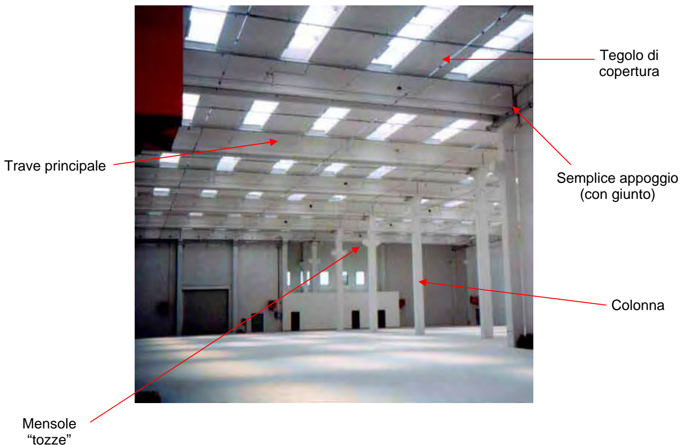
Figura 8.5 – Edificio prefabbricato in c.a.: vista interna
