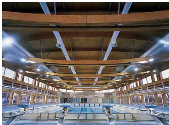
Figura 1.2 Copertura in legno lamellare
