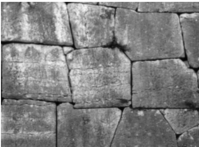
Figura 2.9 Esempio di paramento murario in pietra
