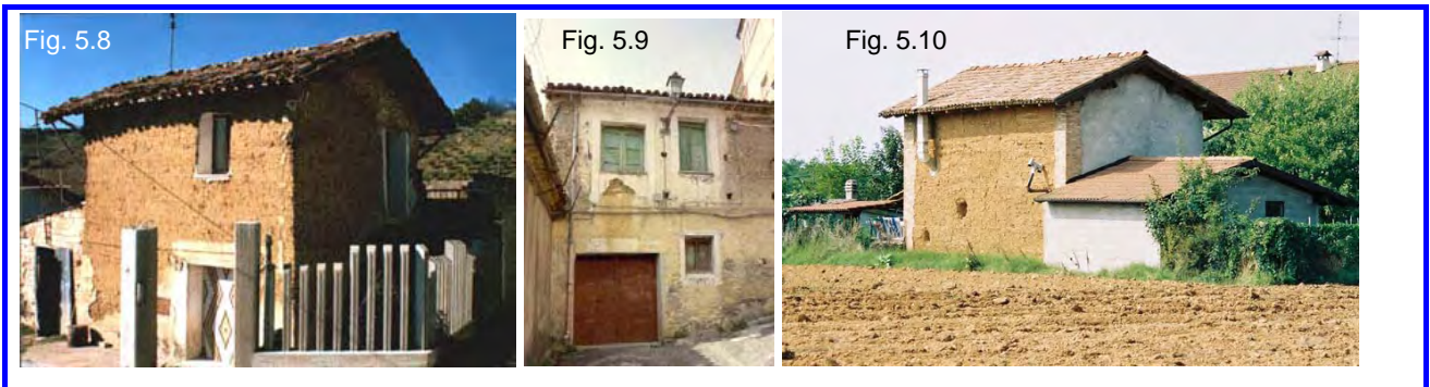
Fig. 5.8 - Edificio di terra nel centro della cittadina di Casalincontrada, in provincia di Chieti, Italia; Fig. 5.9 - Esempio di architettura di terra, costruita con mattoni chiamati "brest", tipico del centro storico della città di Nicastro, in Calabria Fig. 5.10 - Fienile in pisé situato nelle vicinanze di Novi Ligure (AL), Italia;
