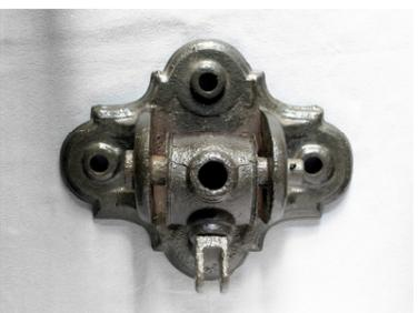
◦ [1] rilievo fotografico dell'elemento di attacco della rete aerea tramviaria, per la distribuzione dell'elettricità
