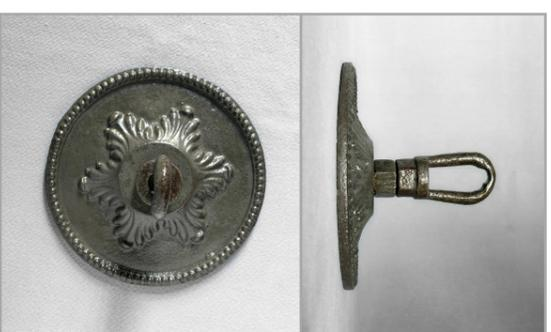
◦ [2] rilievo fotografico dell'elemento di attacco della rete aerea tramviaria, per la distribuzione dell'elettricità
