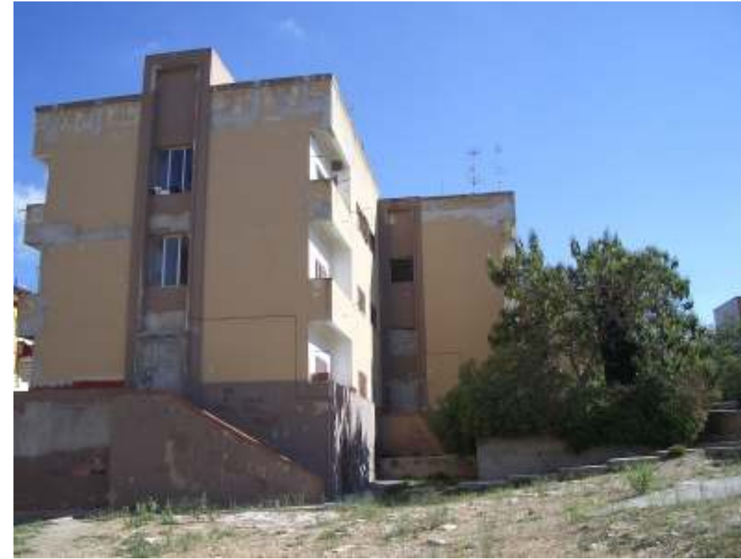
Serramenti in alluminio che chiudono i vani scala.
