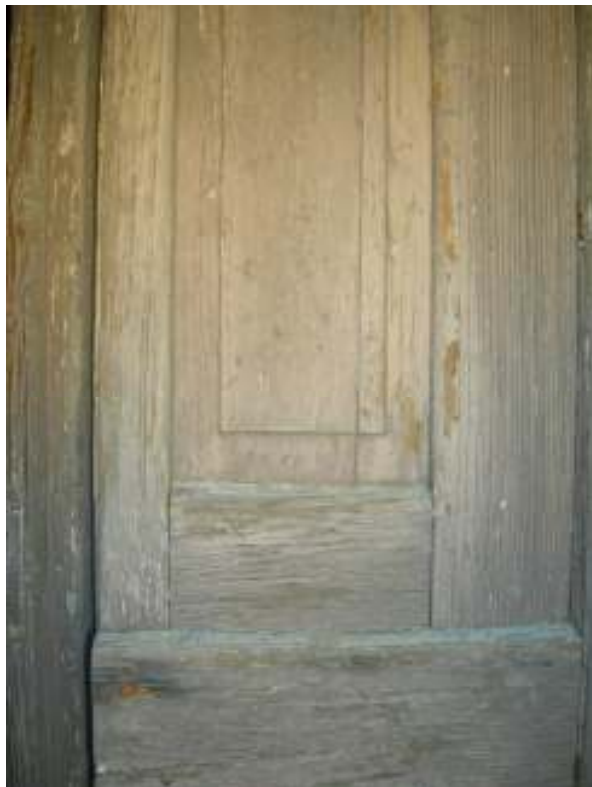
Materiali: portone di ingresso.
