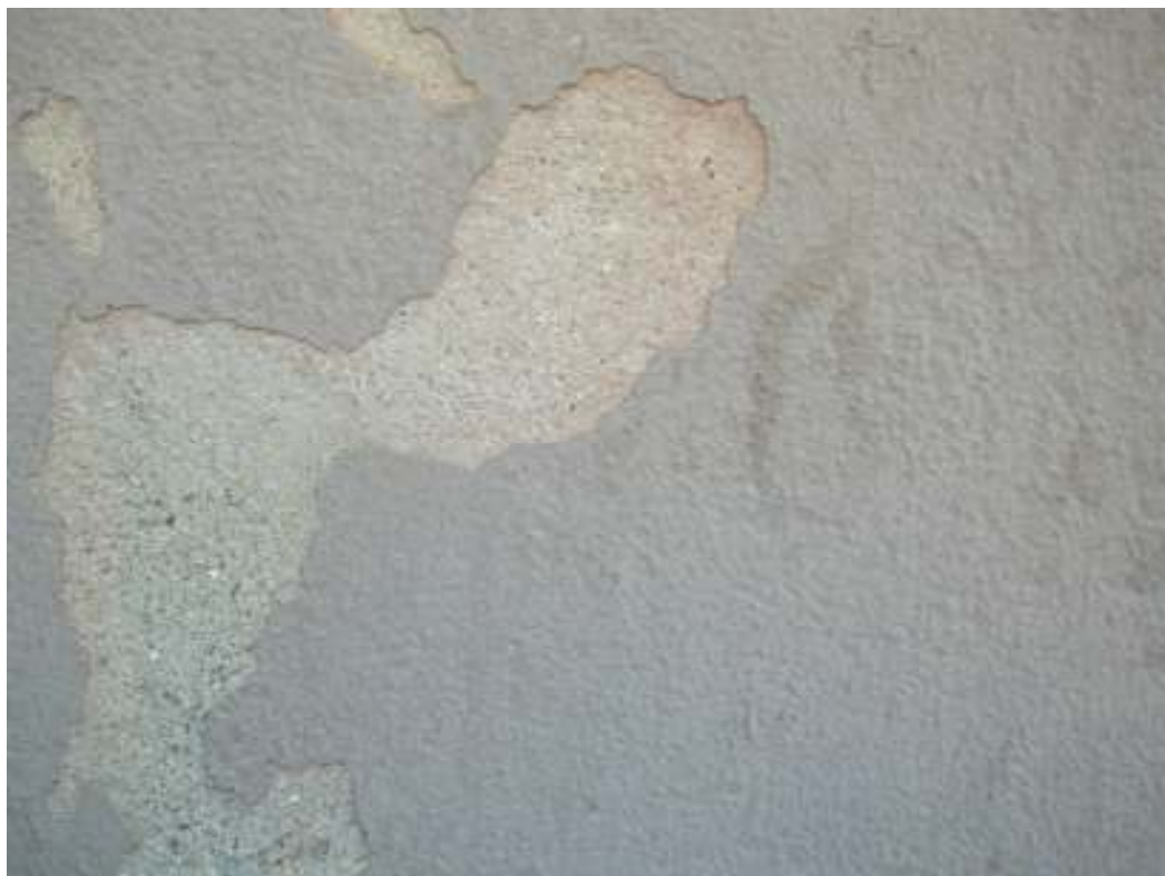
Intonaco esterno. Si nota la grana dell'intonaco sotto la tinteggiatura recente.
