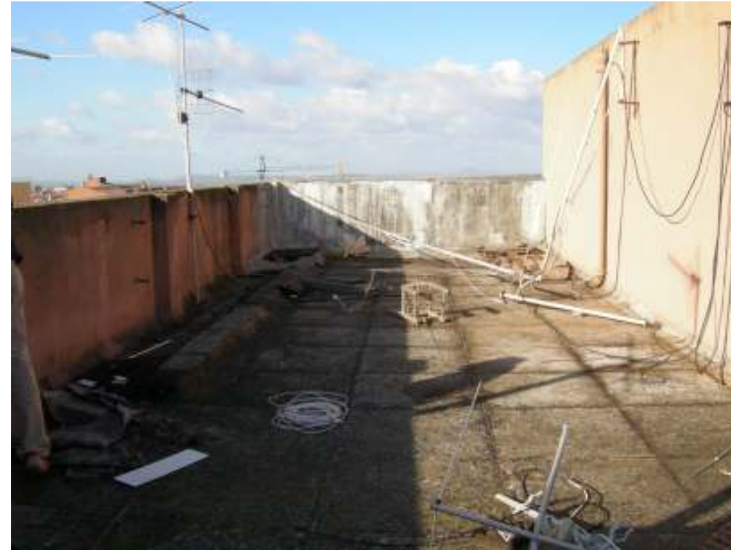
Manto di copertura realizzato in quadrotti di cemento sigillati.
