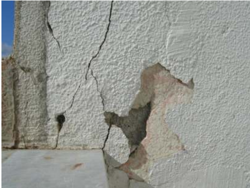
Intonaco della parete laterale di una loggia. Sono visibili gli strati successivi con colori diversi.
