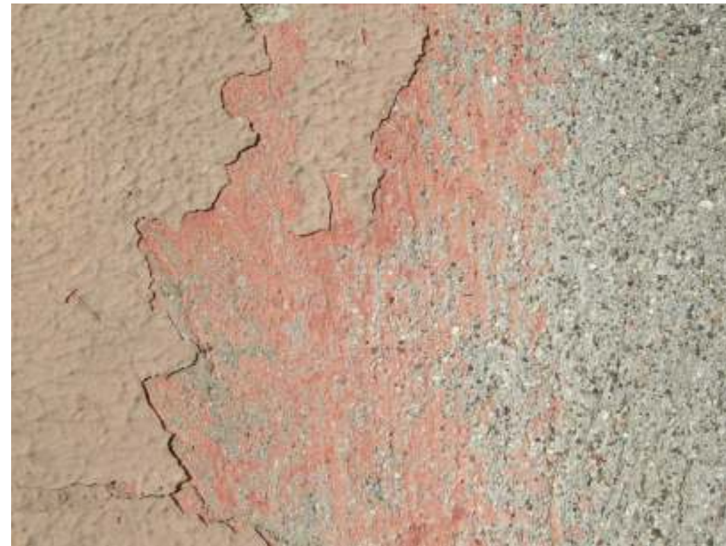
Materiali: intonaco esterno.
