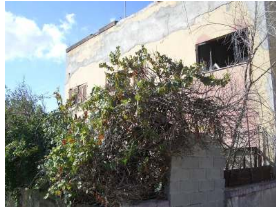
Serramento in legno carbonizzato.
