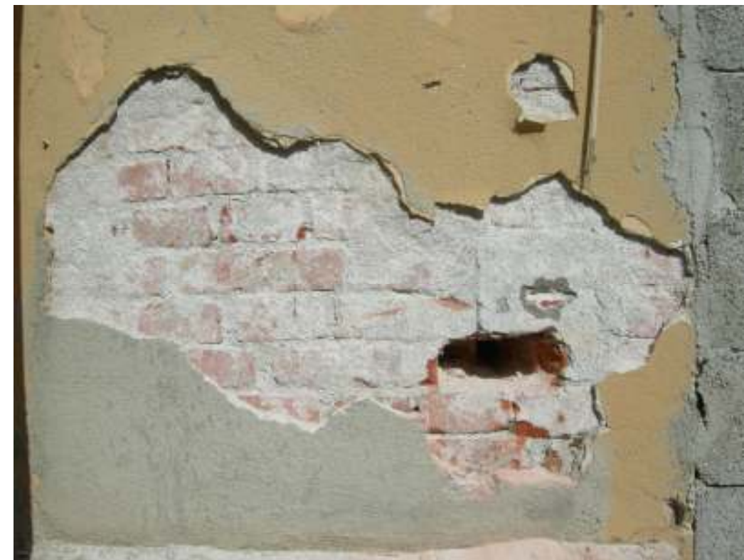
Saggio sulla superficie esterna della muratura perimetrale: si nota la tessitura muraria che rivela la presenza di una parete in mattoni pieni spessa almeno due teste.
