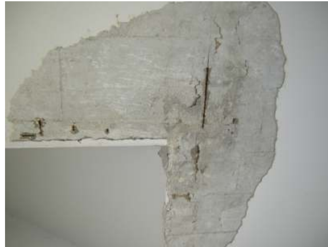
Struttura della rampa delle scale costituita da una soletta piena armata.
