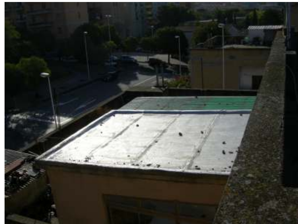
Manto di copertura realizzato con guaina bituminosa.
