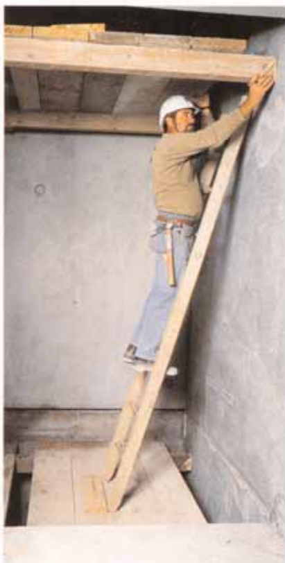
Figura 6 Sulle scale a pioli si può lavorare in modo sicuro solo se si sa usarle secondo le prescrizioni (esatto angolo d'inclinazione, protezione contro scivolamenti al piede, qualitativamente in ordine).
