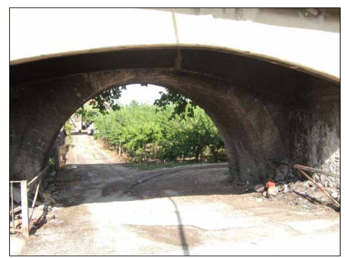
Foto 17: Accesso strada privata (lato nord)
