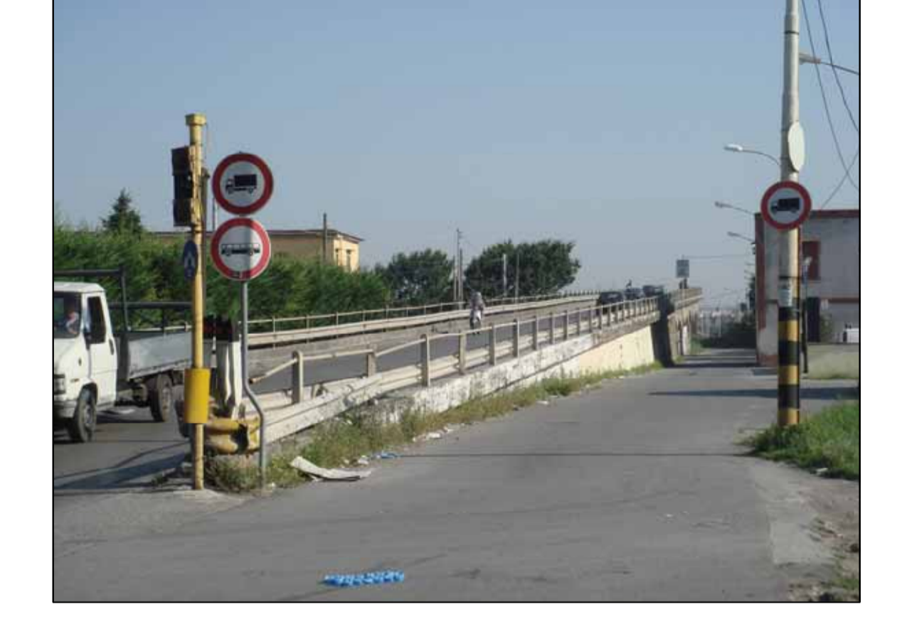
Foto 2: Vista del cavalcavia ed attigua strada comunale da via Fontana
