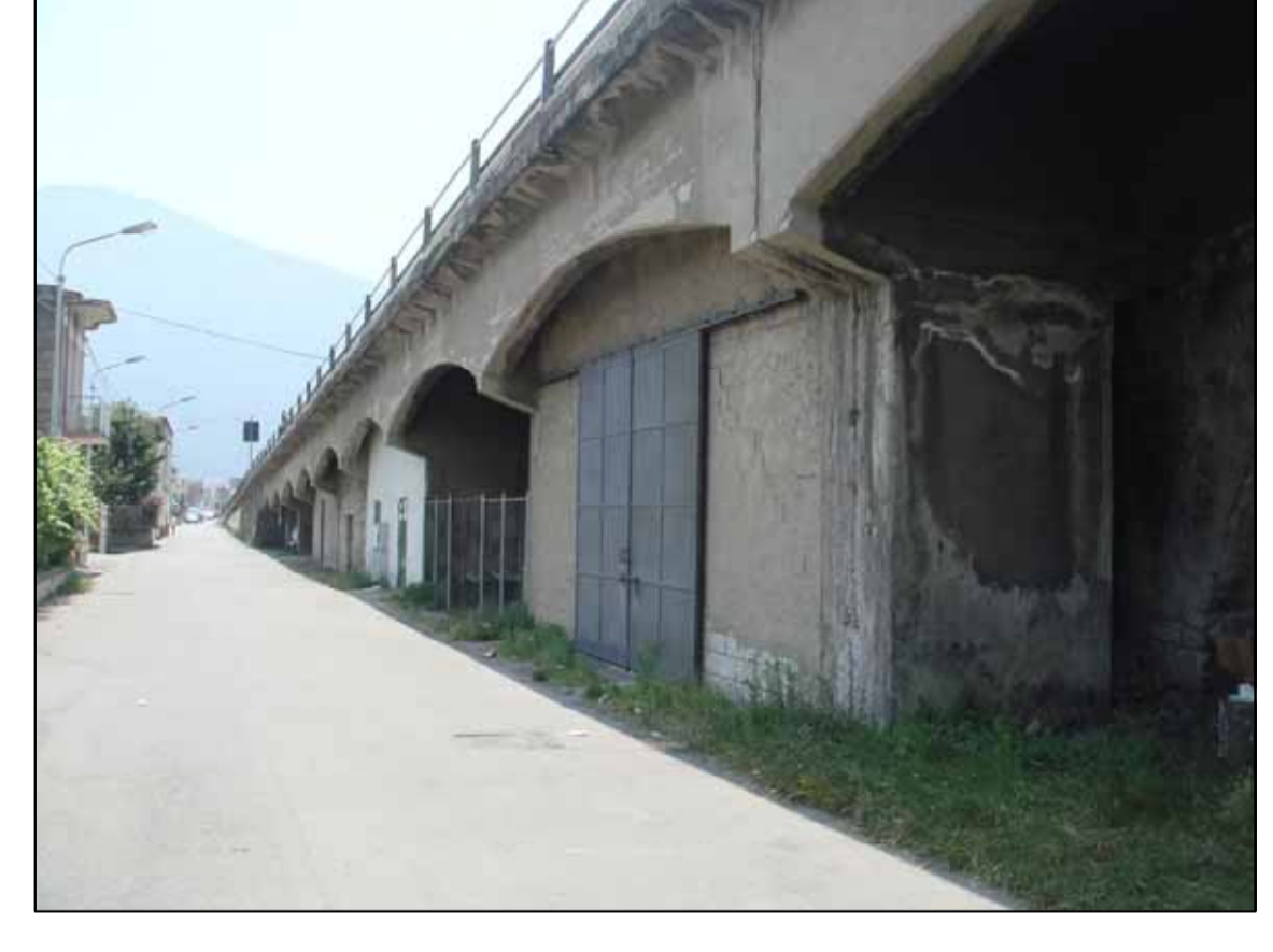
Foto 5: Lato sud, depositi e cabina elettrica
