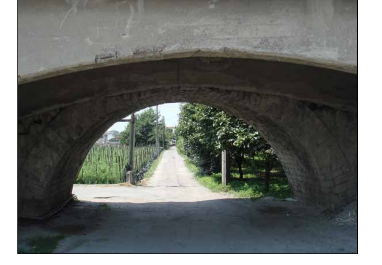
Foto 3: Accesso strada privata (lato sud)
