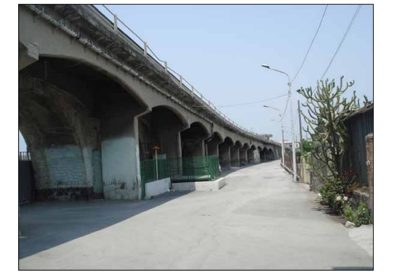
Foto 8: Lato nord, stazione di sollevamento
