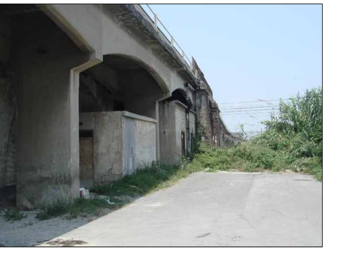
Foto 6: Lato sud, vecchia cabina di trasformazione ENEL
