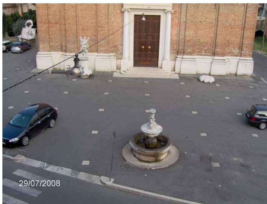
Vista parziale dell'area interessata dall'intervento
