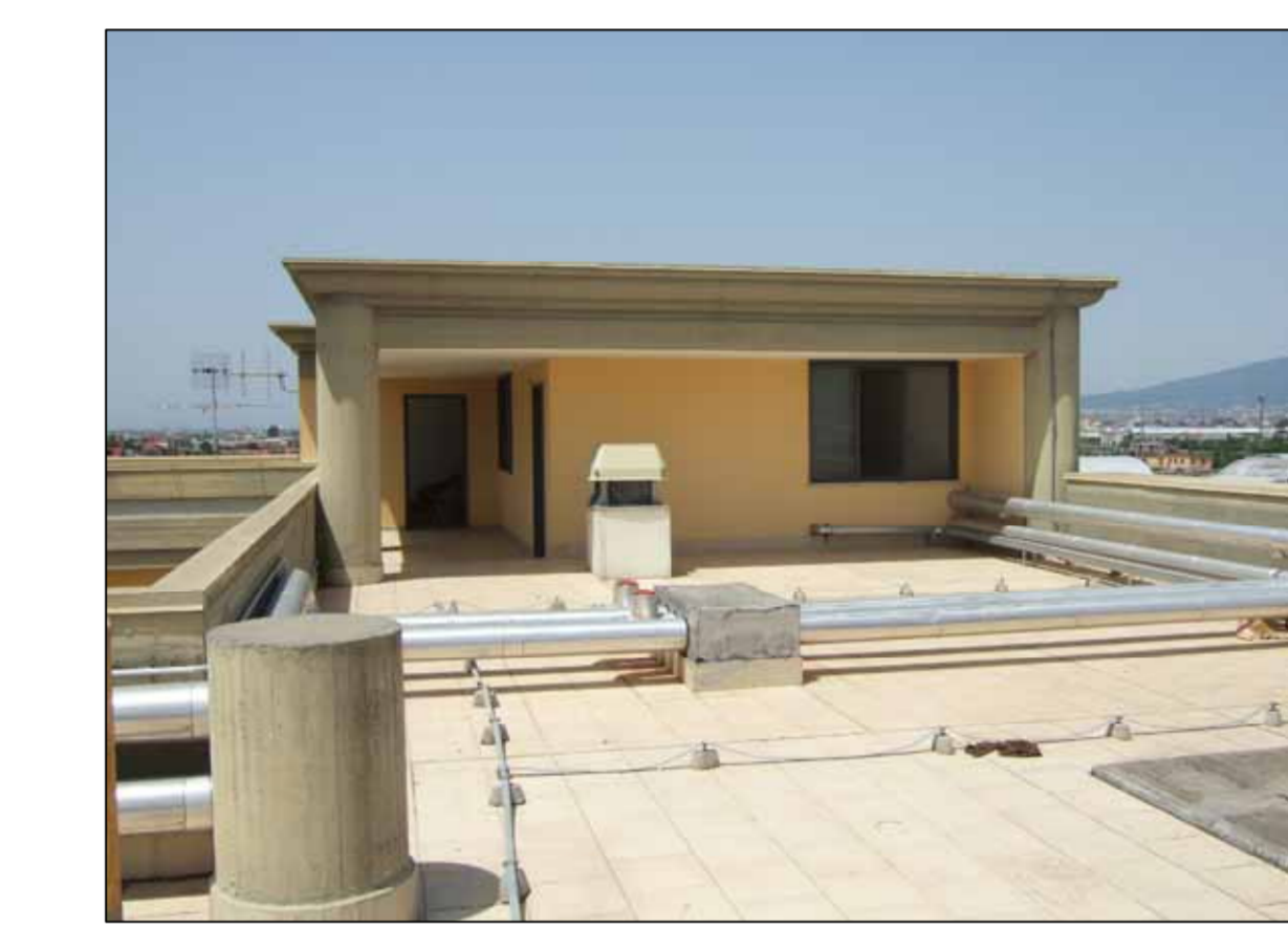
Foto 11: Piano copertura, locale impianti (vista nord)
