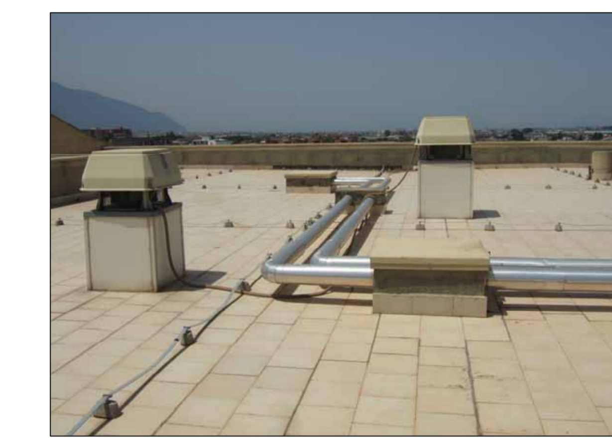
Foto 13: Piano copertura, impianti e camini (vista ovest)
