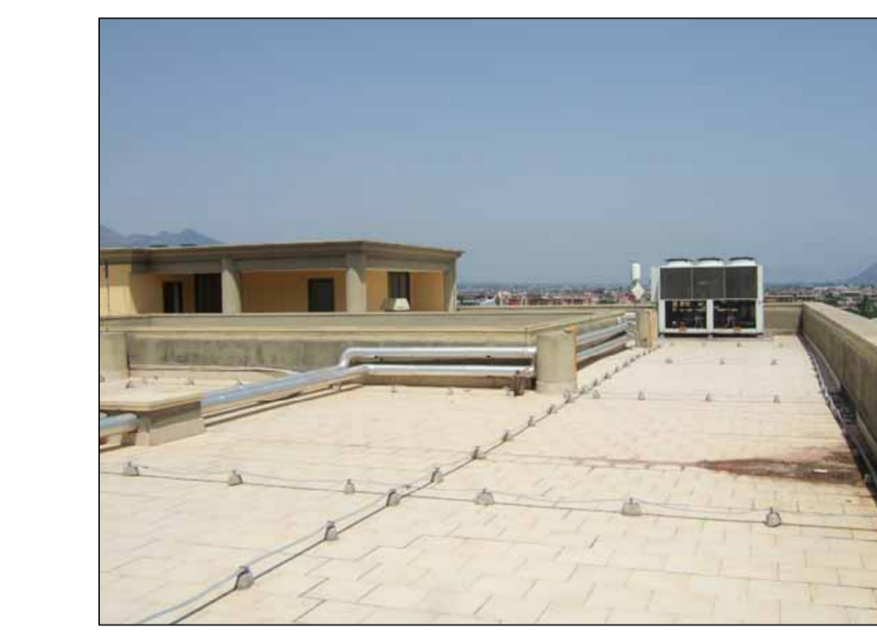
Foto 14: Piano copertura (vista nord)
