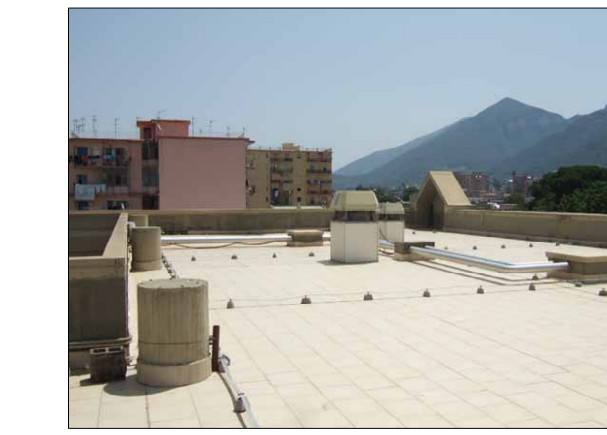
Foto 17: Piano copertura (vista est)
