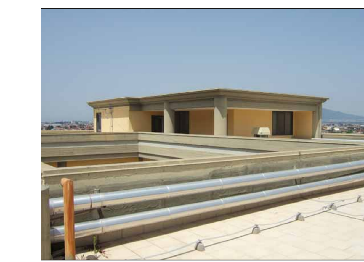
Foto 12: Piano copertura, torrino scale e locale tecnico (vista nprd-est)
