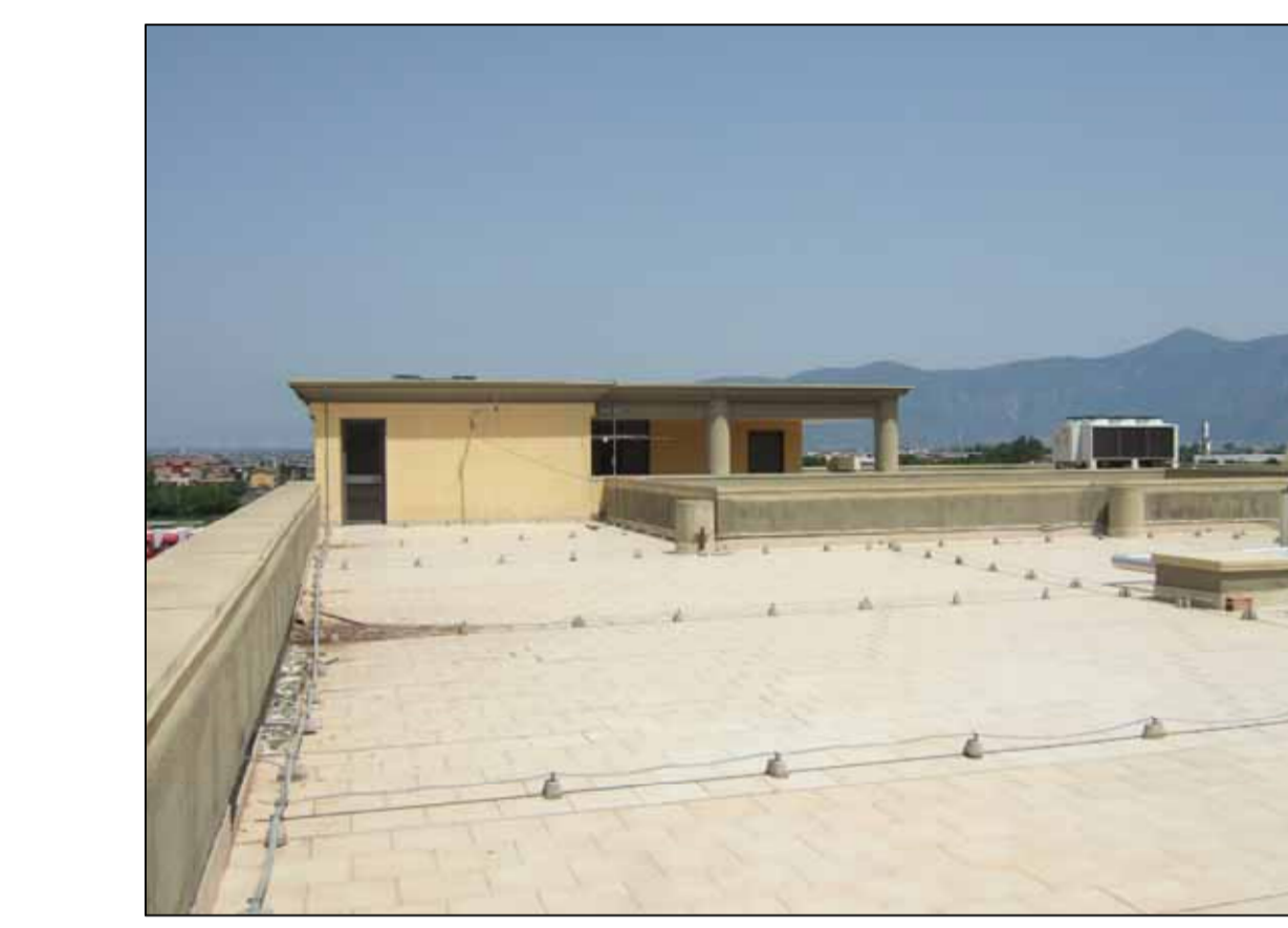
Foto 16: Piano copertura (vista nord)
