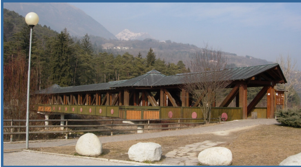
Il ponte in legno pedonale di accesso al parco termale
