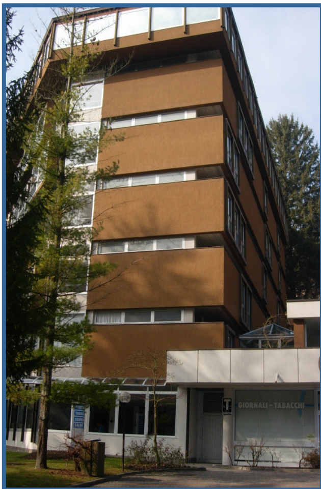
La torre ed il volume a est della torre
