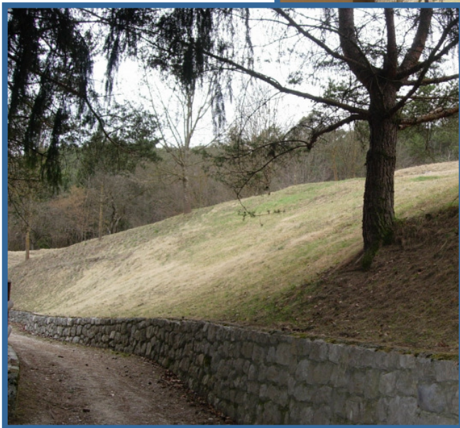
Vista dalla strada interna a monte dello stabilimento verso est
