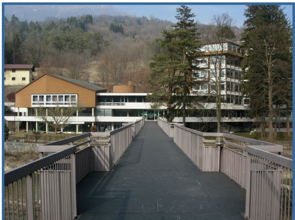
La passerella pedonale dalla S.S. 237 del Caffaro
