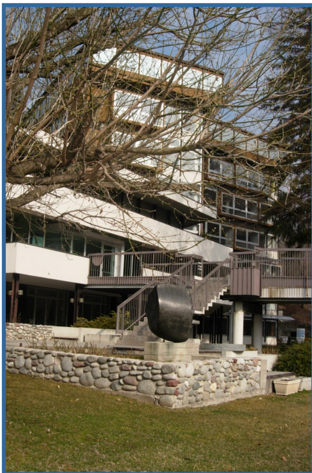
Vista dal parco dell'ingresso principale dello stabilimento e della torre
