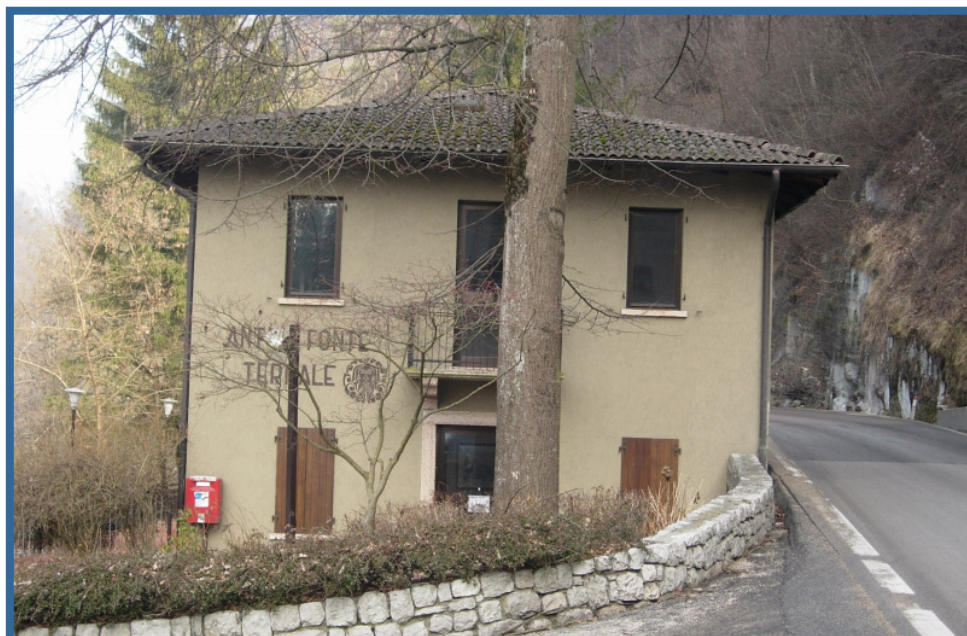
L'ingresso all'antica fonte dalla S.S. 237 del Caffaro
