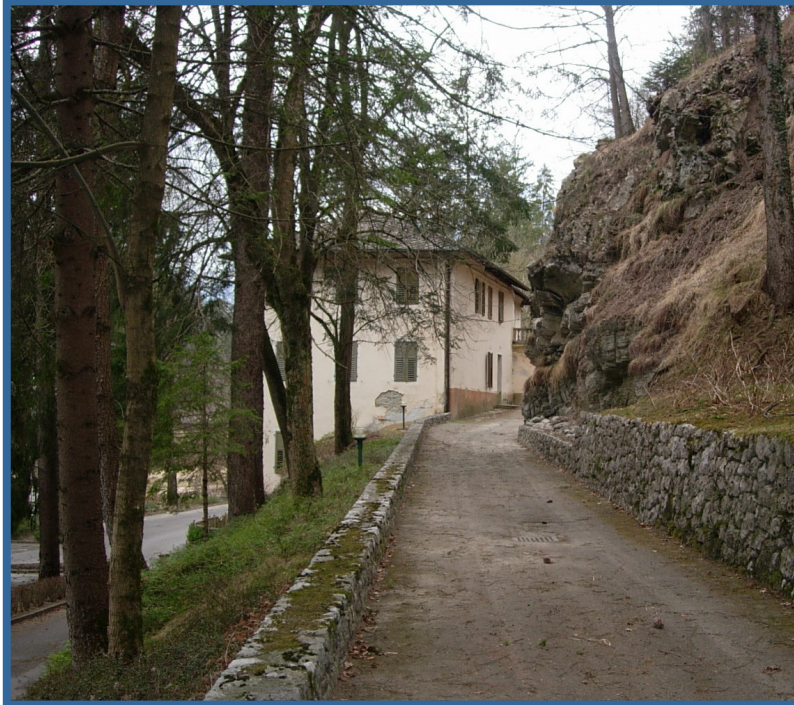
La strada interna che corre lungo il lato nord di Villa Vianini e conduce dietro lo stabilimento termale
