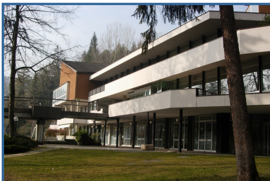
Vista dal parco del corpo principale dello stabilimento e dell'ala ovest
