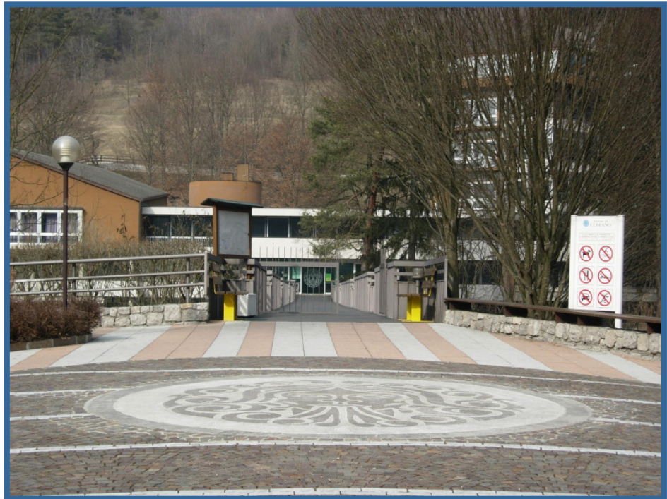
La passerella pedonale dalla S.S. 237 del Caffaro
