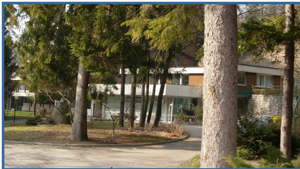
Il volume a est della torre
