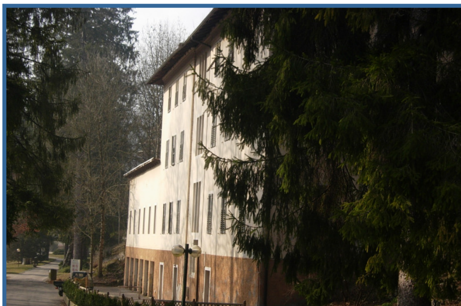
Il prospetto sud di Villa Vianini
