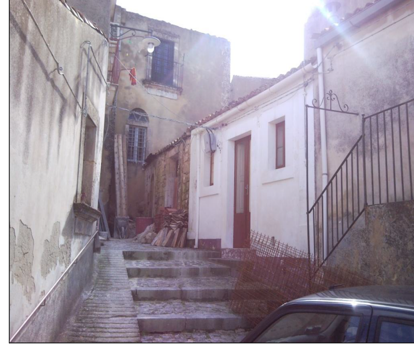
FOTO N.4 - Cortile via Lenza
