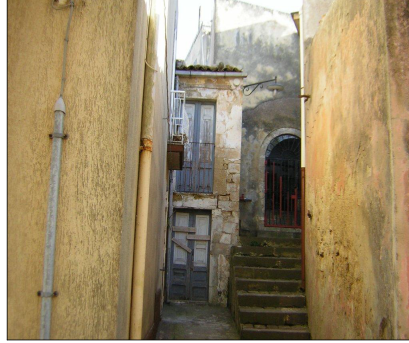
FOTO N.3 - Cortile via Lenza
