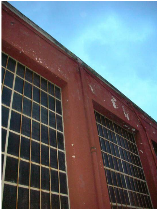
(3.4.3 F) Infissi e vetrate non sono in buono stato di manutenzione
