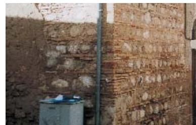
Cast. dei Sauri(FG): muratura di pietrame con ricorsi laterizi
