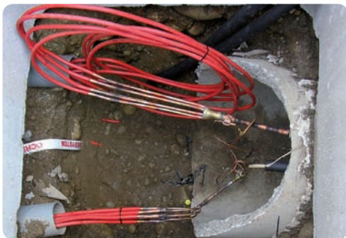
Particolare delle serpentine in rame
