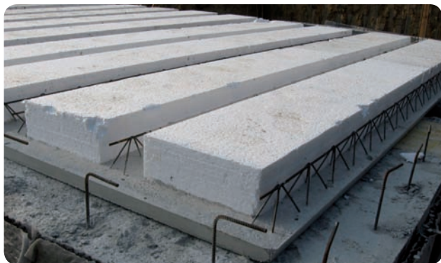
Lastre “predalles” del primo solaio su vespaio aerato
