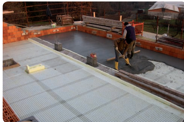
Posa in opera isolamento sottotetto e particolari dell'isolamento
