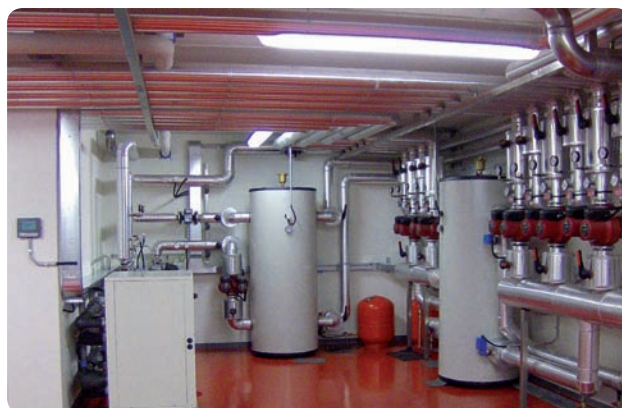
Accumulo del circuito geotermico (al centro della foto) e pompa di calore collegata al prelievo di acqua dalla falda (sulla sinistra della figura)
