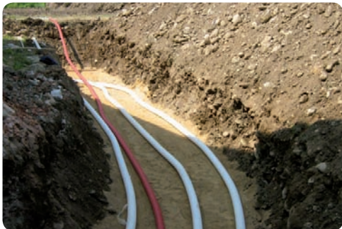
La posa dei tubi interrati di adduzione dell'aria
