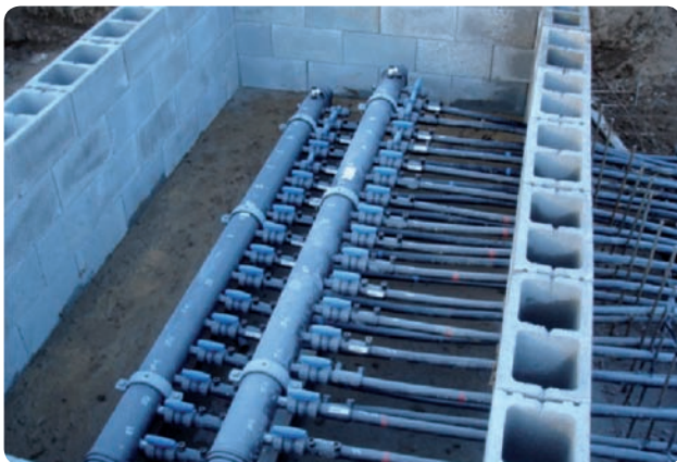
Collettori di collegamento
