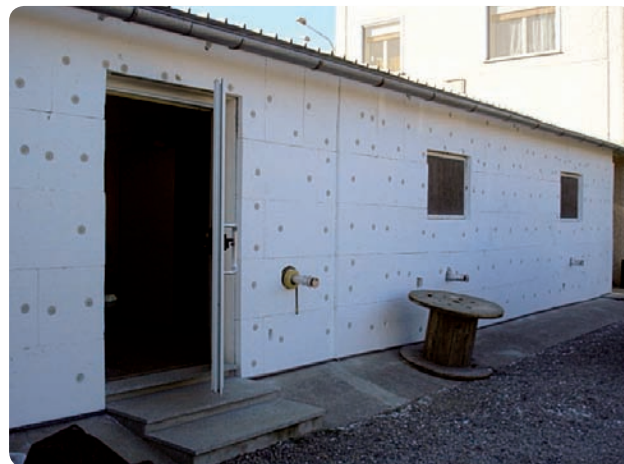
Installazione termocappotto in polistirene
