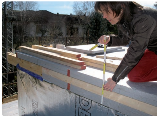
Posa isolamento del tetto
