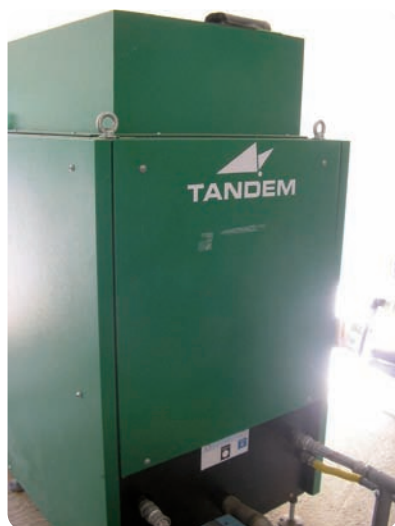
Cogeneratore da 50 kW.
