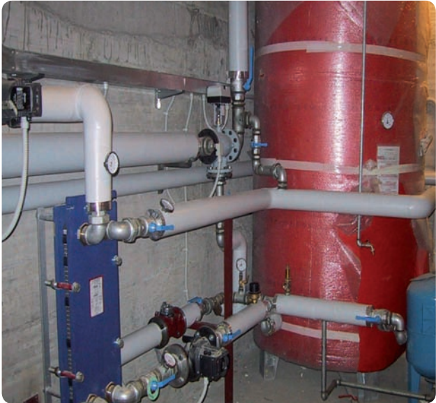
Sistema di accumulo acqua calda sanitaria
