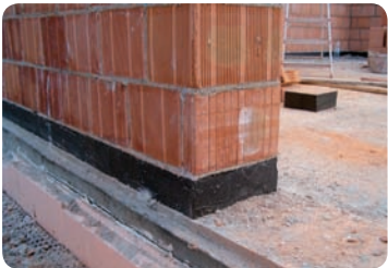
Particolare del primo corso realizzato in vetro cellulare
