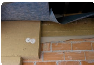
Raccordo del cappotto con il pacchetto isolante del tetto
