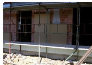
La parte inferiore del cappotto (zoccolatura) è costituita da un polistirene estruso resistente ad eventuali infiltrazioni umide.
