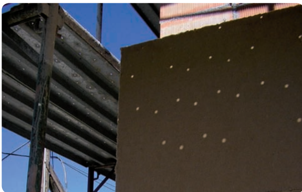
Particolare cura è richiesta per la posa degli angoli del cappotto in fibra di legno
