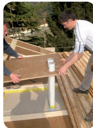
Inserimento pannelli fibre di legno sulle prese d'aria sigillate
