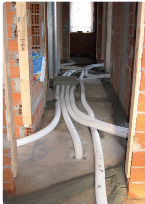
Rete di distribuzione dell'aria di ricambio
