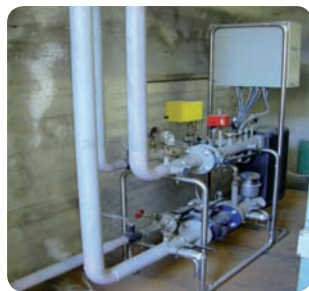
Sottocentrali di scambio: da sinistra in alto 800, 300, 200 e 350kW
