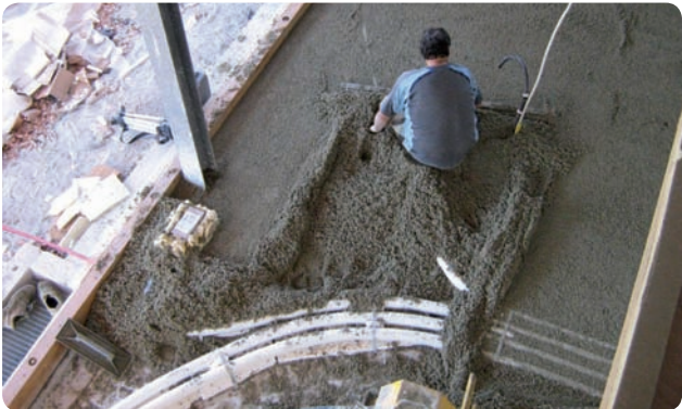
Particolare della posa del materiale coibente di livellamento ("Softground")
