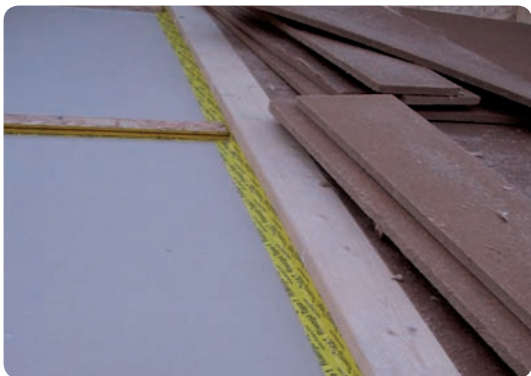
Posa pannelli isolanti in fibra di legno
