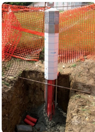
Preso d'aria esterna dell'impianto VMC
