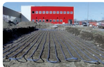
Scavo e disposizione sonde orizzontali
