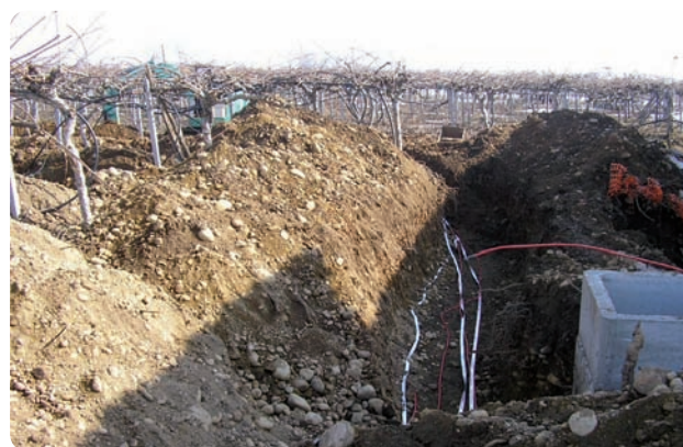
Disposizione dei collettori orizzontali
