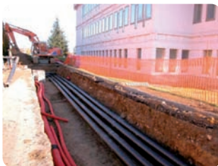
La rete di teleriscaldamento
