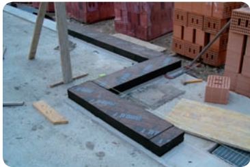
Particolare del primo corso realizzato in vetro cellulare
