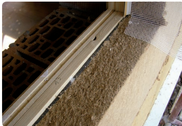
Sezione delle pareti perimetrali in corrispondenza del serramento
