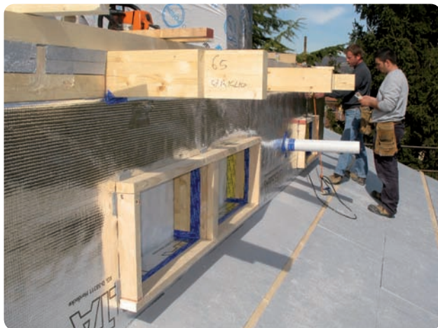
Isolamento dell'abbaino
