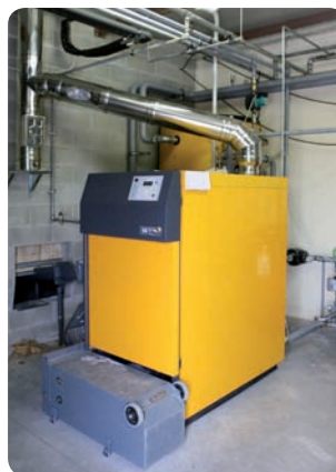
Caldaia a cippato
