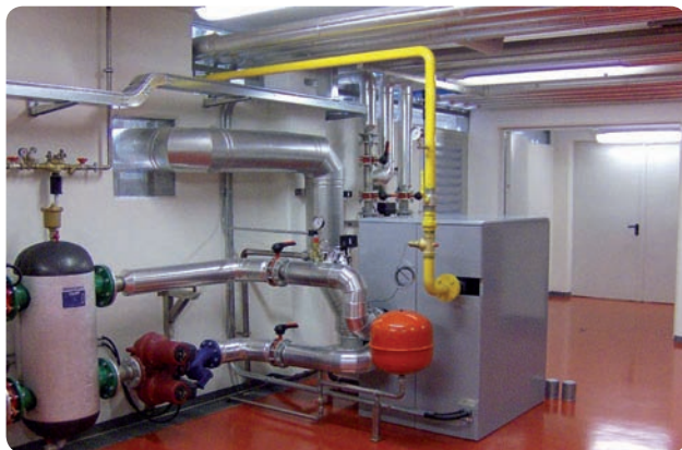
Collegamento tra caldaia e collettore di mandata per mezzo di un separatore collettore; rampa del gas di alimentazione caldaia con organi di controllo.
