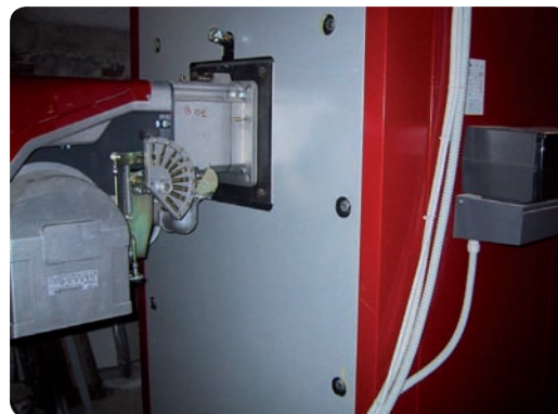
Caldaia a condensazione e bruciatore
