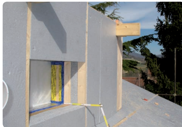
Isolamento dell'abbaino
