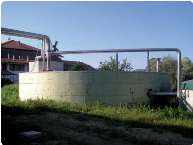
Fermentatore coperto per la fermentazione del substrato, con rispettivo riscaldamento (contenitore in cemento armato)
