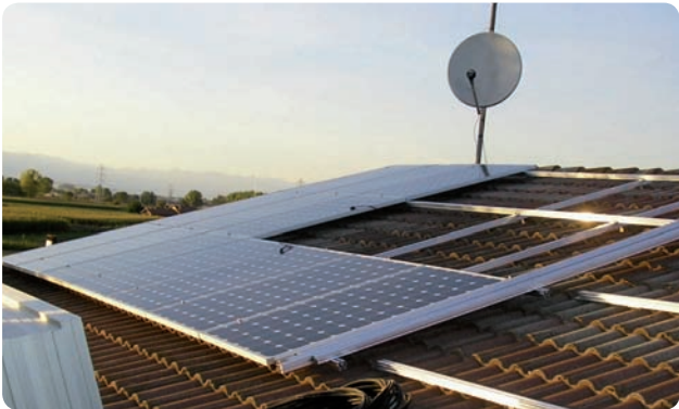
Impianto fotovoltaico
