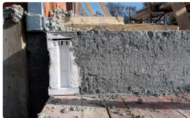
Il modulo di isolamento del balcone in opera
