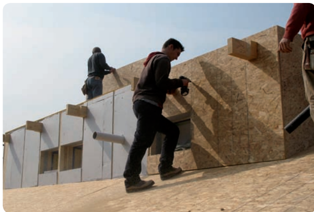
Posa pannelli OSB su copertura ed abbaino
