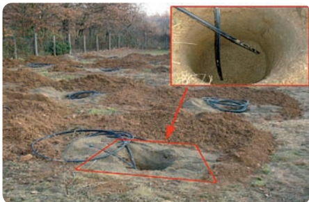
Basket geotermico posato nello scavo
