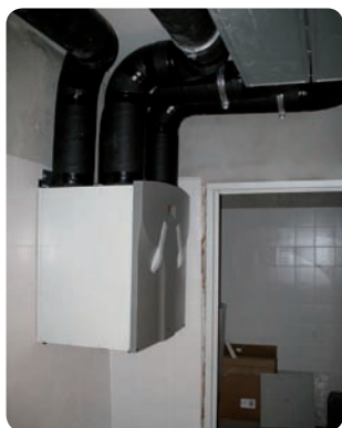
Impianto di ventilazione meccanica controllata - recuperatore di calore
