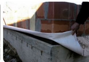
Il ponte termico verso le fondazioni viene attenuato con l'utilizzo di foam glas
