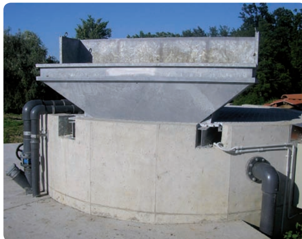
Pre-vasca per la raccolta del refluo
