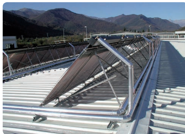
I pannelli solari sulla copertura della piscina
