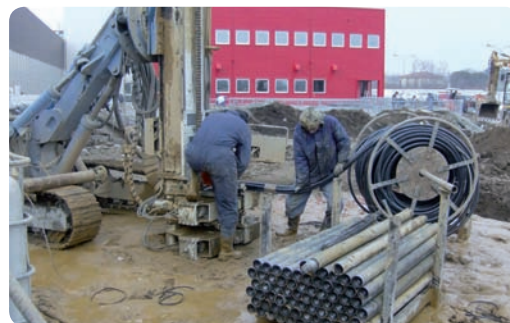
Realizzazione della sonda verticale: fase di inserimento della sonda all'interno del tubo di perforazione
