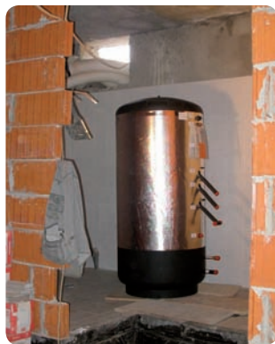
Impianto solare termico - bollitore
