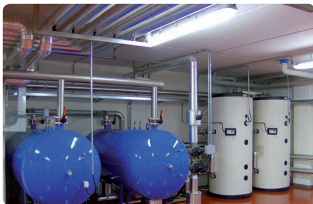
Accumuli dell'acqua ad alta temperatura per gli impianti di prova (accumuli verticali di colore bianco) e accumuli dell'acqua miscelata in ritorno dagli impianti di prova (accumuli orizzontali di colore blu).
