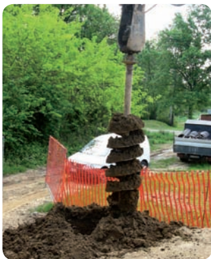
Scavo del foro per la posa dei basket
