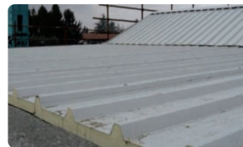
Posa in opera isolamento sottotetto e particolari dell'isolamento
