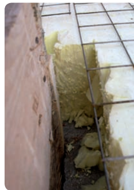
Posa in opera isolamento sottotetto e particolari dell'isolamento
