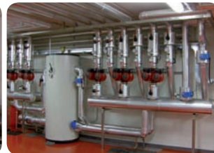
Accumulo dell'acqua refrigerata proveniente dal chiller e collettore di mandata all'impianto di raffreddamento
