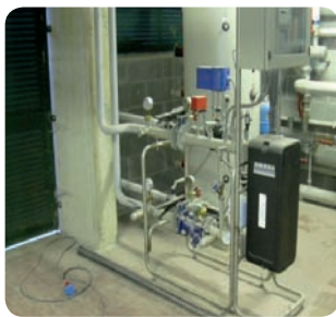
Sottocentrali di scambio: da sinistra in alto 800, 300, 200 e 350kW
