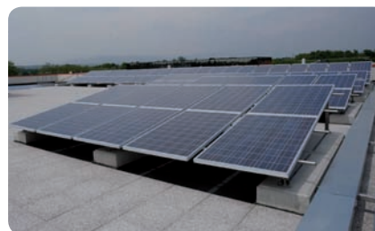
Disposizione dei moduli fotovoltaici in copertura; si può notare la suddivisione in gruppi
