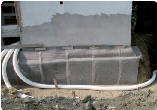
Ventilazione meccanica controllata - posa dei tubi interrati
