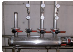
Collettore di mandata e separatore idraulico
