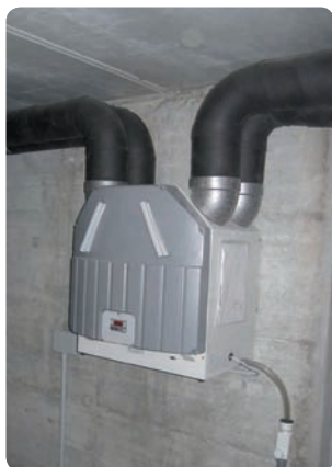
Il recuperatore di calore dell'impianto VMC
