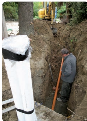
Ventilazione meccanica controllata - posa dei tubi interrati
