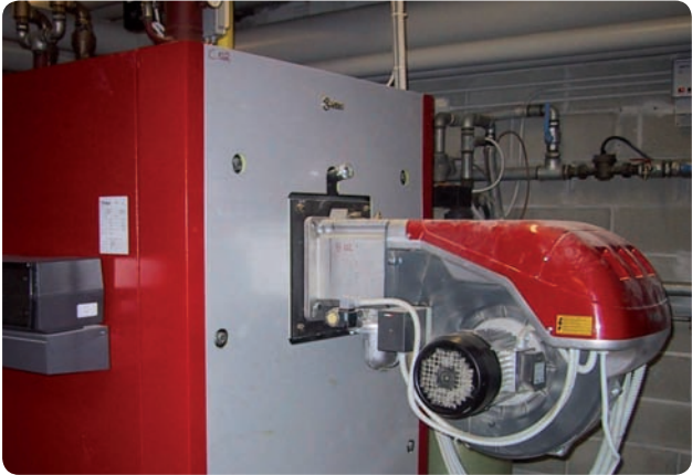
Caldaia a condensazione e bruciatore
