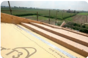
La coibentazione del tetto durante la posa
