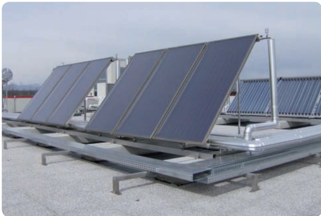
Nella figura si possono osservare le due tipologie di pannelli solari installati: in primo piano i pannelli solari piani, sullo sfondo i pannelli solari sottovuoto.
