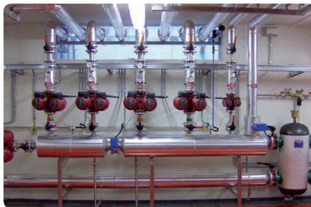
Collettore di mandata e separatore idraulico
