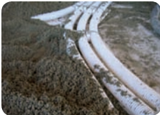
Particolare della posa del materiale coibente di livellamento ("Softground")
