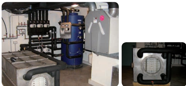
La centrale termica: in primo piano l’accumulo con PCM
