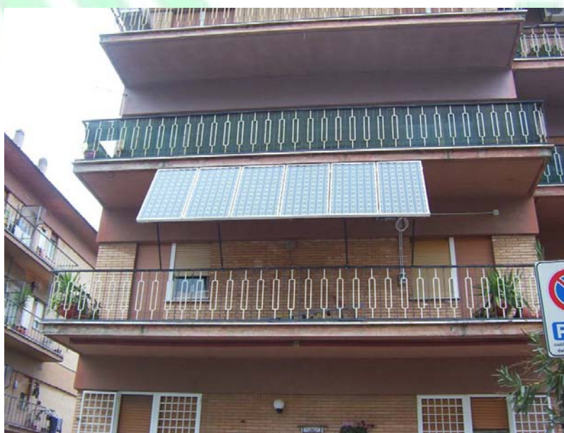
Figura 19 - Esempio di installazione non idonea alla classificazione dell’impianto fotovoltaico nella categoria “su edifici” – Motivazione: la lunghezza dell’impianto fotovoltaico supera il doppio della lunghezza delle aperture trasparenti sottese
