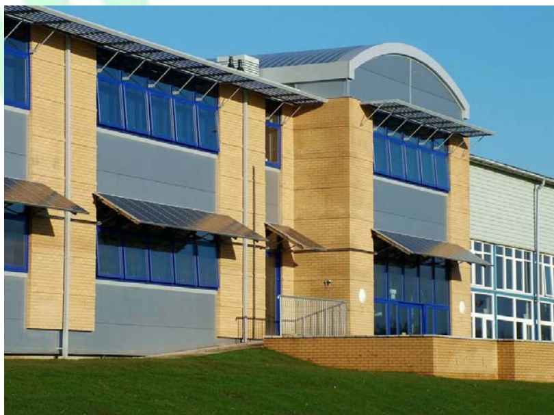
Fig.17 – Esempio di installazione idonea alla classificazione dell'impianto fotovoltaico nella categoria "su edifici"
