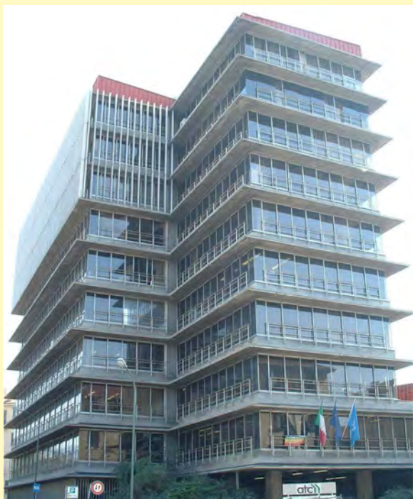
Sede ATC di Torino in fase di ristrutturazione
