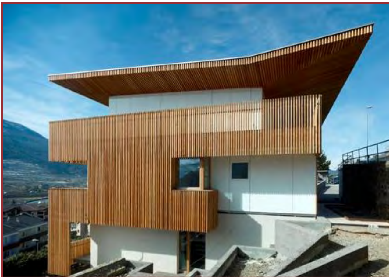
Edificio unifamiliare ristrutturato a Pergine Valsugana (TN), foto Architettura Sostenibile
