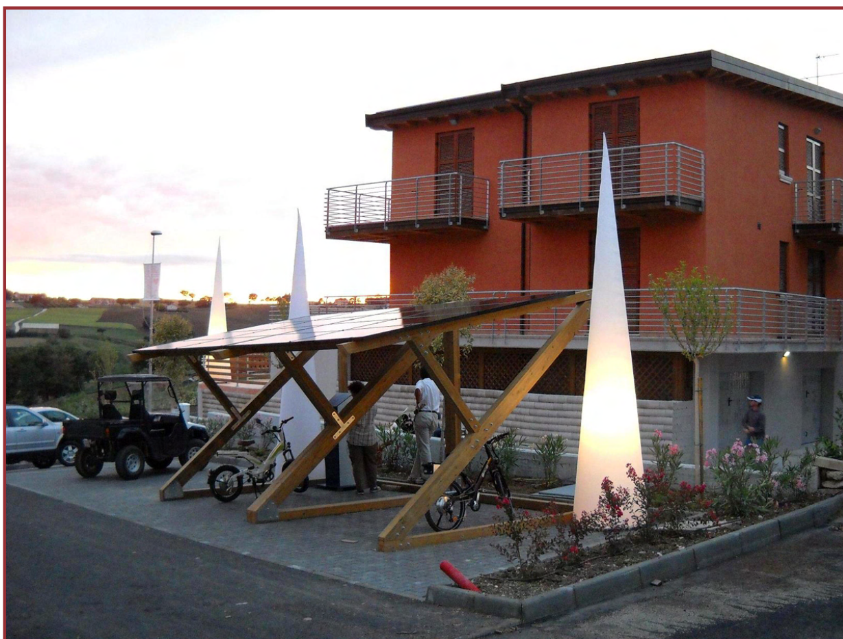
Edificio in classe A del complesso "Casa Solare" con parcheggio fotovoltaico, Santa Maria Nuova (AN)
