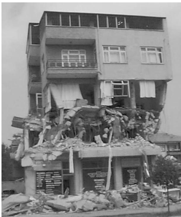
Figura 4.35 Danno gravissimo a struttura a telaio di cemento armato, con distruzione di parte dei pilastri del primo piano e del solaio del secondo. Livello del danno: D4-D5 (Turchia, 1999)
