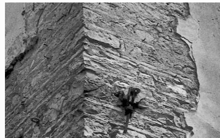
Benevento: muratura di pietrame con ricorsi laterizi
