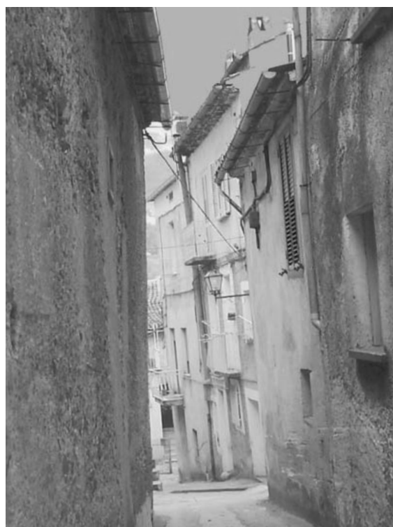
Figura 4.5 Fuori piombo preesistenti in un antico centro storico. Livello del danno preesistente per l'edificio: D1
