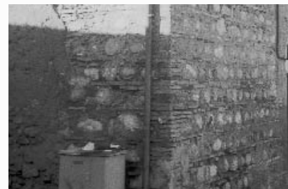
Cast. dei Sauri (FG): muratura di pietrame con ricorsi laterizi
