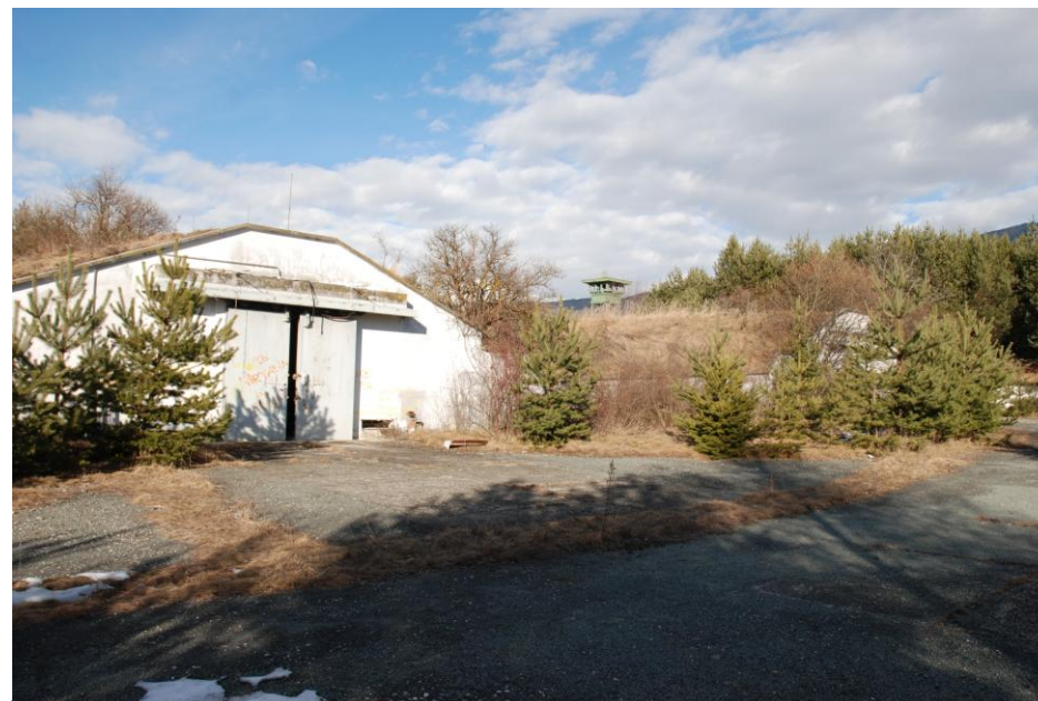
Immagine di entrambi i bunker.
