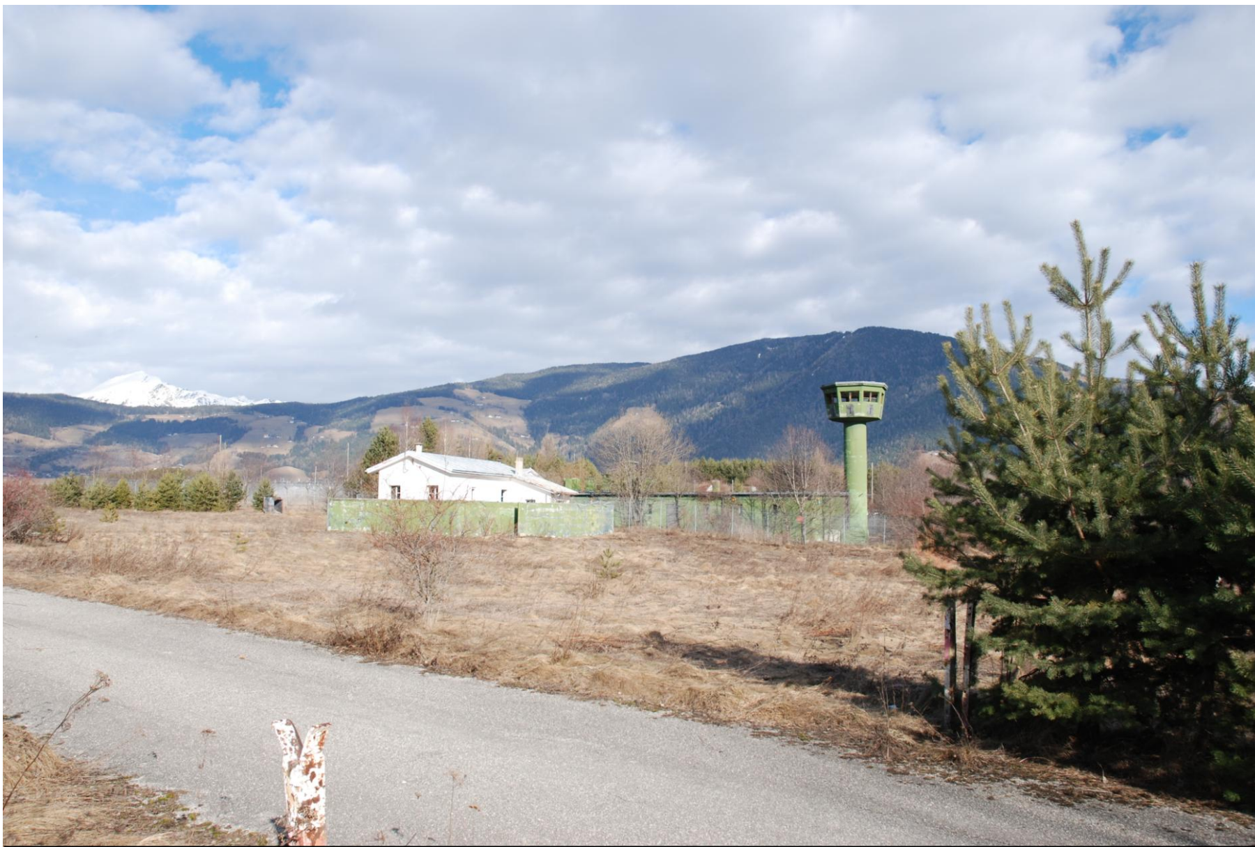
Visuale dall'entrata in direzione nordest, in vista il fabbricato nr. 1 con torre di vigilanza 1.
