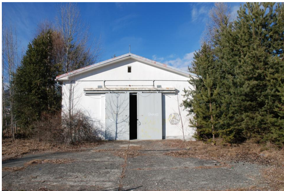
Immagine del fabbricato nr. 2.
