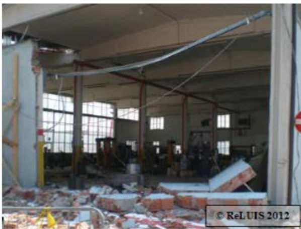
Figura 44 – Collasso e fessurazione del pannello di tamponatura in laterizio in una struttura prefabbricata monopiano di non recente costruzione
