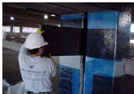
Figura 89 – Fasciatura di pilastro in FRP
