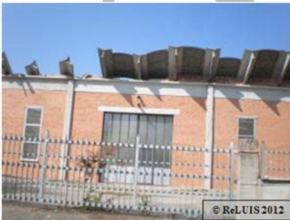
Figura 21 – Collasso della copertura con tegoli ad Y
