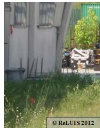
Figura 50 – Perdita di verticalità del pilastro per rottura alla base per cause non accertabili
