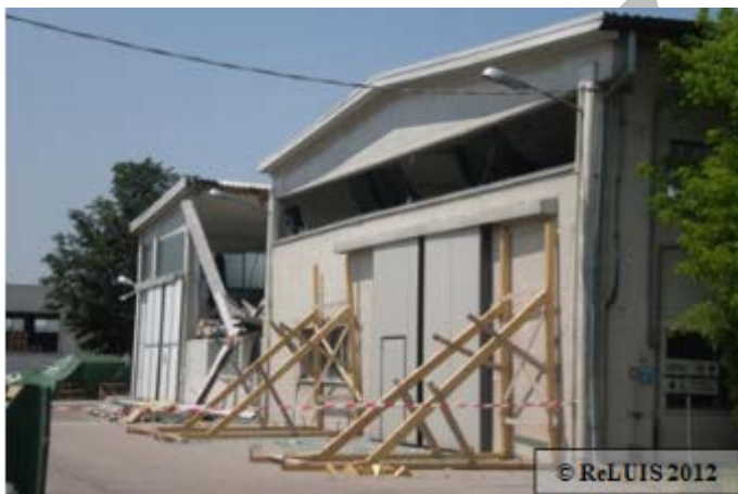
Figura 45 - Collasso incipiente per meccanismo fuori dal piano dei pannelli in laterizio in una struttura prefabbricata monopiano di non recente costruzione
