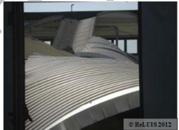
Figura 12 - Perdita di appoggio della trave per rottura connessione in un edificio con trave principale trasversale
