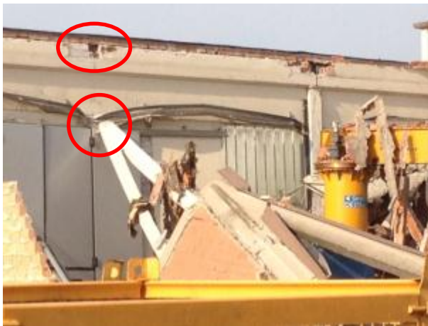
Figura 15 – Collasso della copertura per perdita di appoggio in un edificio monopiano prefabbricato con trave principale longitudinale
