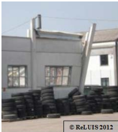
Figura 50 – Perdita di verticalità del pilastro per rottura alla base per cause non accertabili
