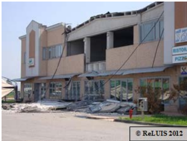
Figura 33 – (a) Crollo dei pannelli orizzontali di tamponamento in una struttura monopiano prefabbricato: (b) dettaglio ancoraggio pannelli in corrispondenza dei pilastri
