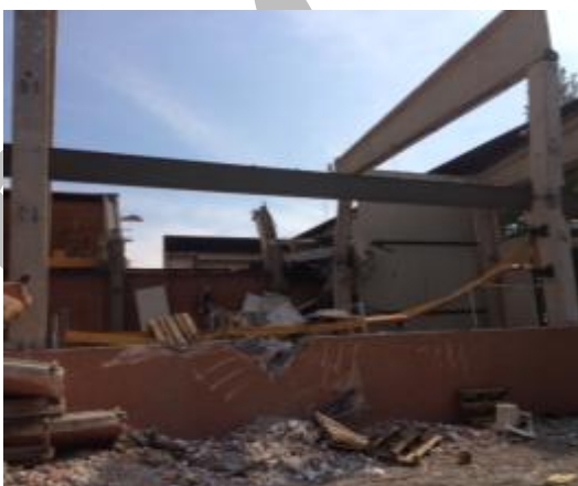
Figura 34 – (a e b) Crollo di pannelli orizzontali di tamponamento in un edificio monopiano prefabbricato e (b) dettaglio profili a C in corrispondenza del pilastro
