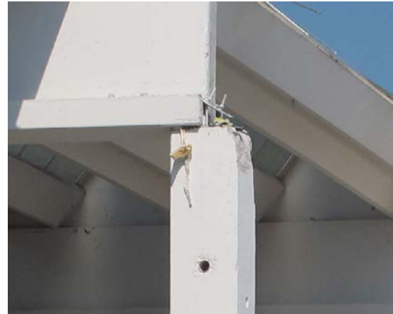
Figura 12 - Perdita di appoggio della trave per rottura connessione in un edificio con trave principale trasversale
