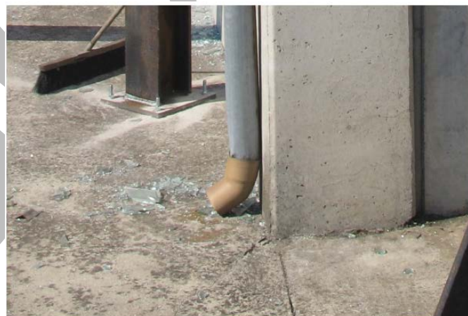
Figura 55 – Rotazione alla base del pilastro
