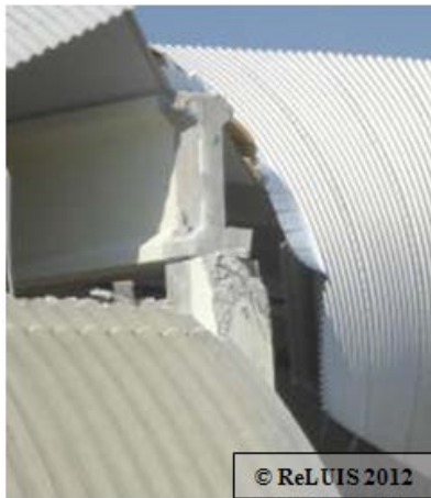
Figura 12 - Perdita di appoggio della trave per rottura connessione in un edificio con trave principale trasversale
