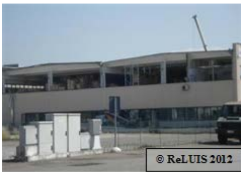
Figura 27 – Collasso pannelli orizzontali di tamponamento in strutture monopiano prefabbricate
