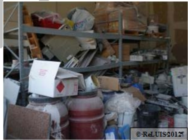
Figura 63 – Danneggiamento scaffalatura con conseguente perdita del materiale contenuto
