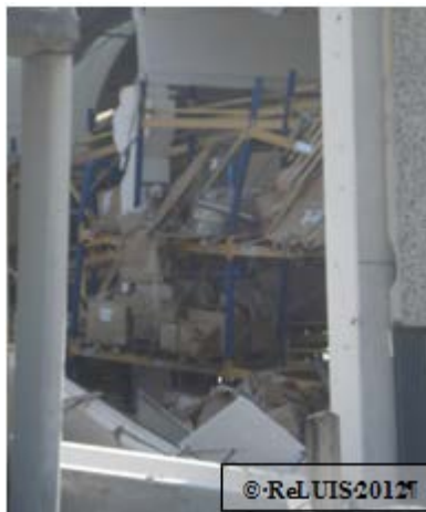
Figura 65 – Collasso scaffalature e conseguente perdita di contenuto
