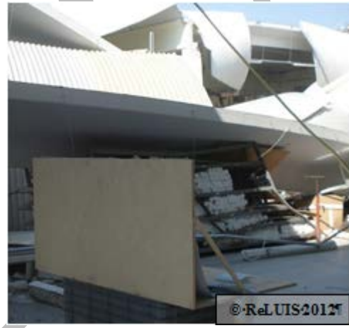
Figura 65 – Collasso scaffalature e conseguente perdita di contenuto
