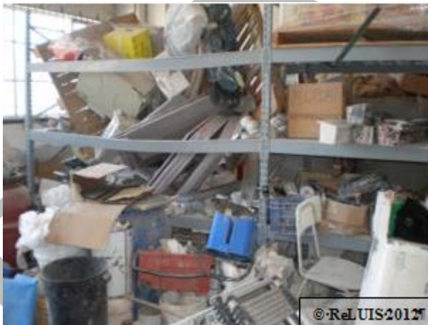
Figura 63 – Danneggiamento scaffalatura con conseguente perdita del materiale contenuto
