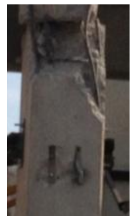
Figura 34 – (a e b) Crollo di pannelli orizzontali di tamponamento in un edificio monopiano prefabbricato e (b) dettaglio profili a C in corrispondenza del pilastro
