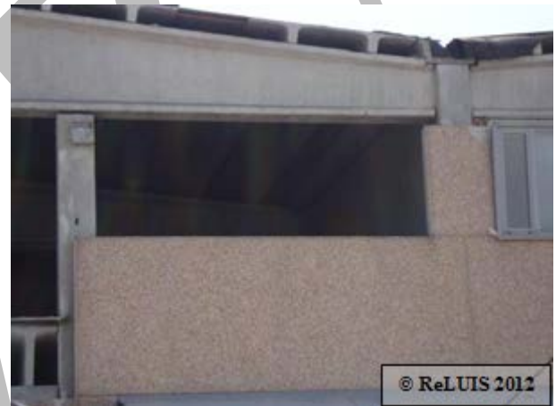
Figura 33 – (a) Crollo dei pannelli orizzontali di tamponamento in una struttura monopiano prefabbricato: (b) dettaglio ancoraggio pannelli in corrispondenza dei pilastri
