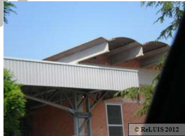
Figura 21 – Collasso della copertura con tegoli ad Y
