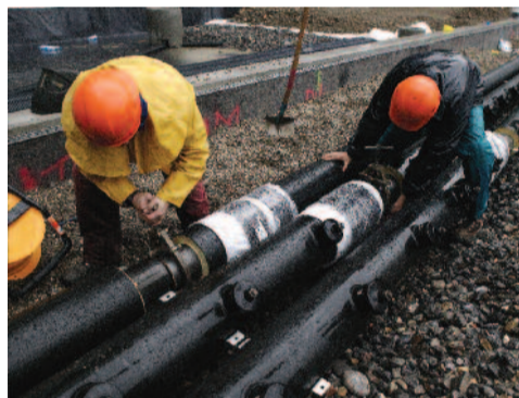
Prime fasi di cantiere
