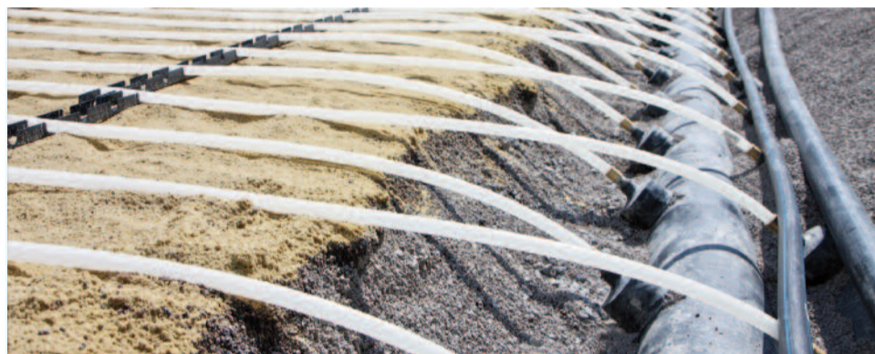
Fasi della posa del sistema REHAU presso l'Arena Lviv in Ucraina
