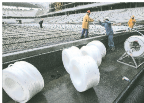
Posa dei circuiti sotto il campo di gioco
