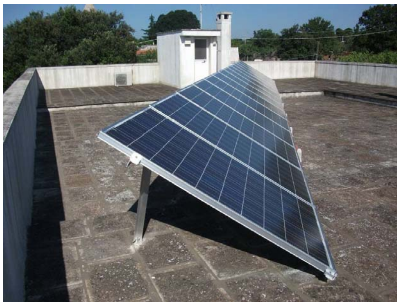
Figura 4 – Esempio di installazione idonea alla classificazione dell’impianto fotovoltaico nella categoria “su edifici” in caso di presenza di una balaustra perimetrale
