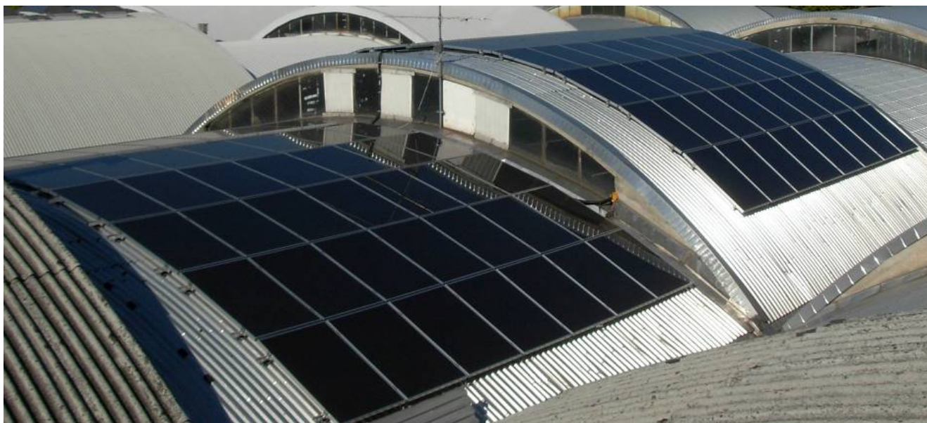
Fig.14 – Esempio di installazione idonea alla classificazione dell’impianto fotovoltaico nella categoria “su edifici” in caso di installazione su una superficie di copertura curva
