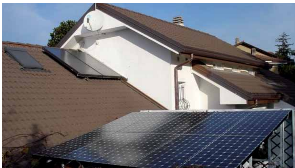
Abitazione con pannelli fotovoltaici e solare termico
