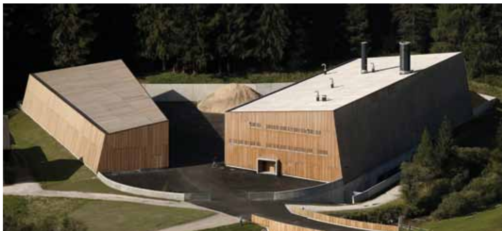
Impianto di teleriscaldamento nel Comune di Sesto (BZ)
