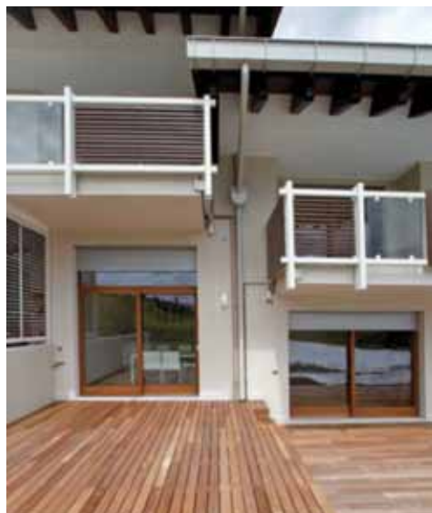
Edificio plurifamiliare, Feltre (BL) Casa Clima classe B
