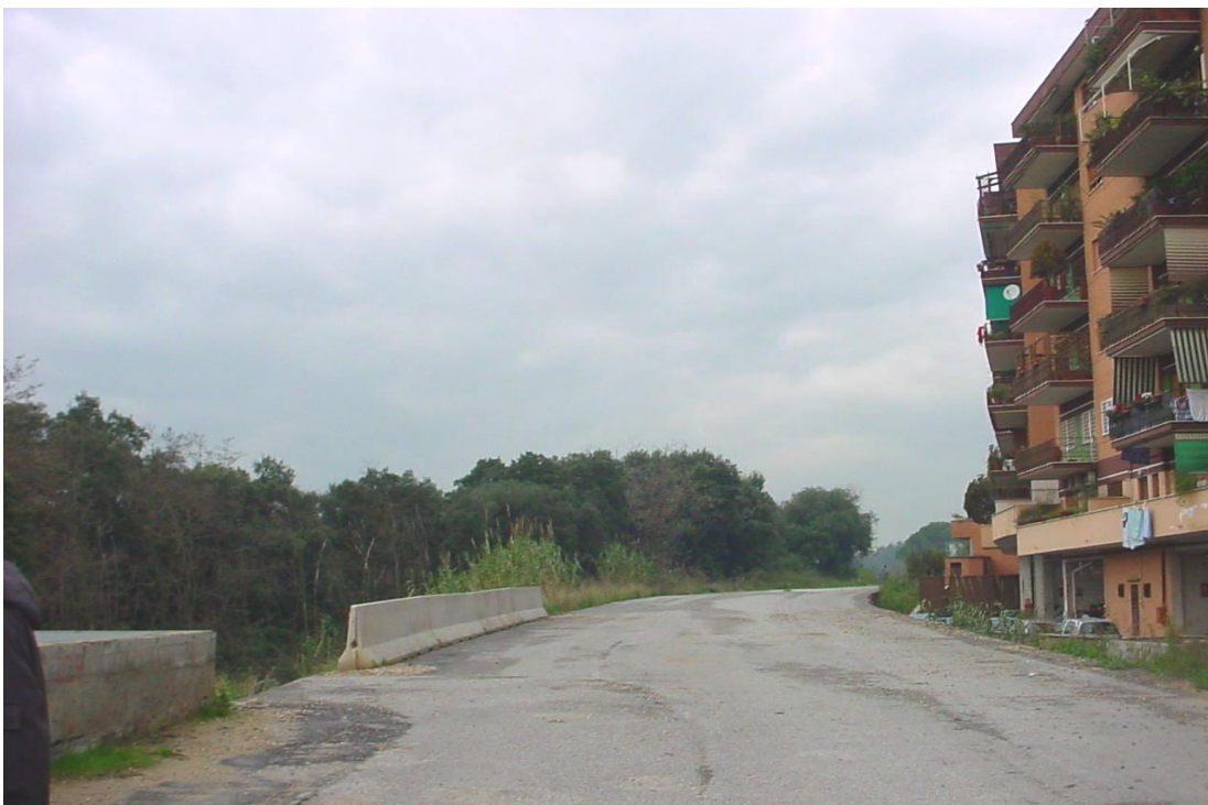
Fig 3.2 B – Alcune immagini dell'intervento di copertura della linea eseguito da FS.
