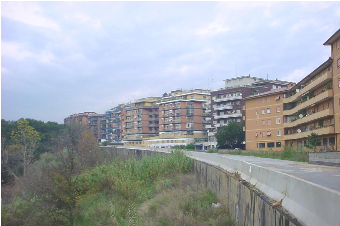
Fig 3.2 A – Alcune immagini dell'intervento di copertura della linea eseguito da FS.
