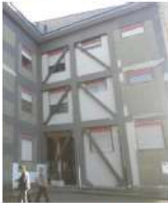
Parte interessata del precedente intervento di adeguamento
