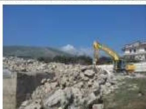
Fase di demolizione
