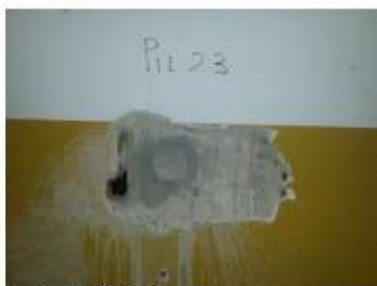
Seggio sulla struttura in c.a.
