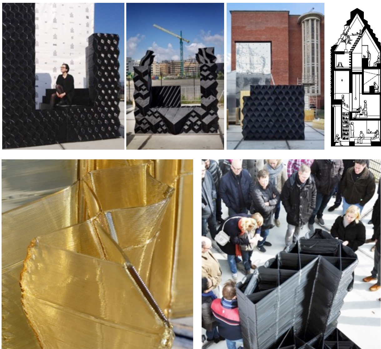
Figura 18 "3D Print Canal House" 18 , rendering, schema costruttivo e sezione dell'abitazione, fotografie dei singoli elementi realizzati attraverso la stampa 3D
