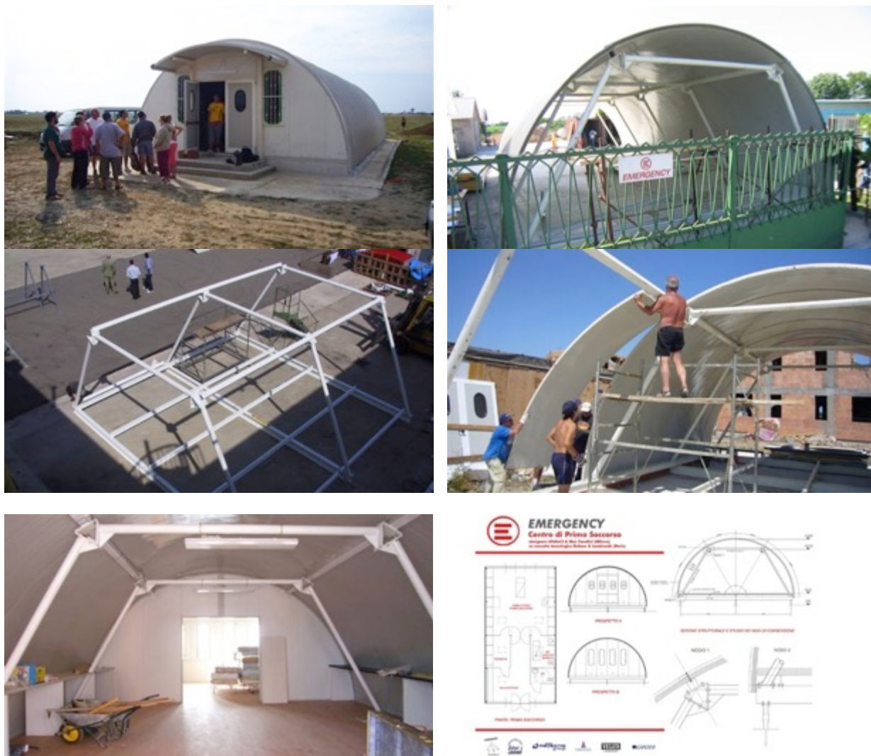
Figura 5 "First Aid Post (FAP)" 6 fotografie delle fasi di montaggio e estratto di tavola
