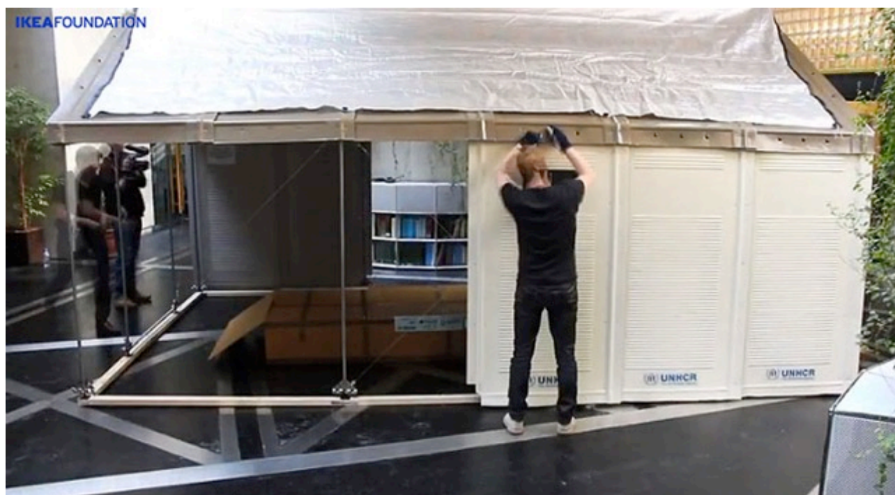
Figura 4 “Refugee Housing Unit” 5 , rendering del modulo costruito, esploso, e fotografia del montaggio
