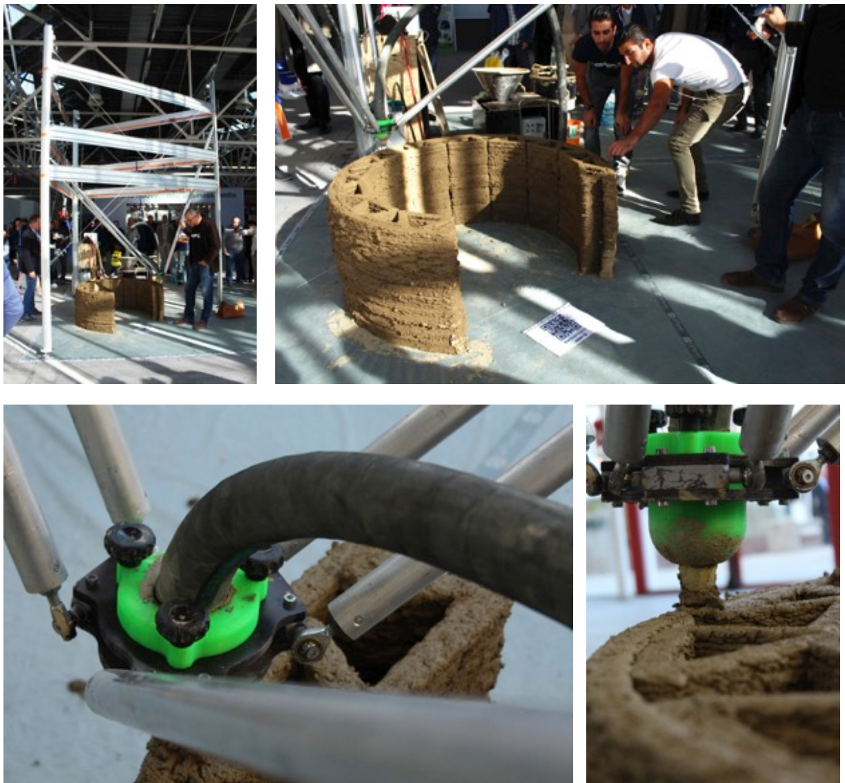
Figura 19 WASProject stampante “BigDelta” 23 , fotografie della stampa di un elemento
