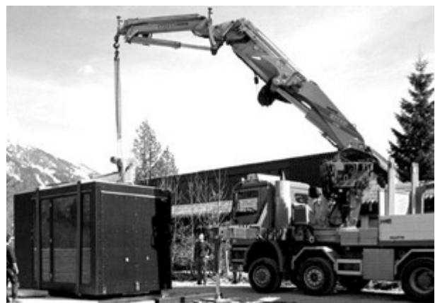
Figura 7 "FRED" 8 , foto della messa in opera della struttura abitativa
