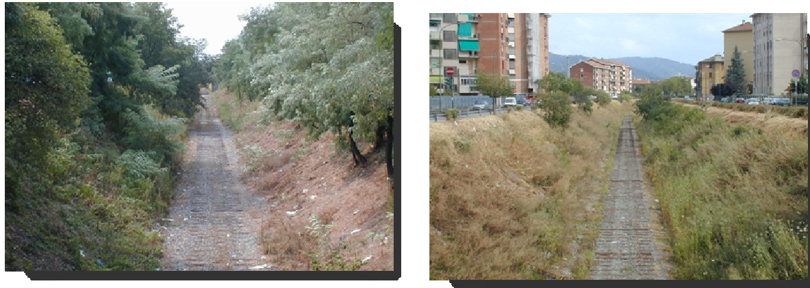
trincea ferroviaria – stato di fatto
