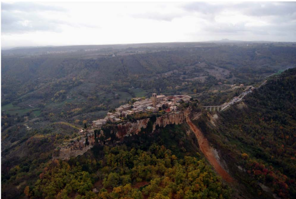
Figura 5.16 - Frana nel versante settentrionale di Civita di Bagnoregio
