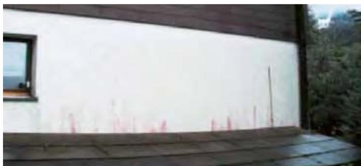
2. Contaminazione algale su una parete per accumulo di acqua in prossimità dell'innesco parete-tettoia. Il degrado raggiunge un'altezza di 1,60 m.
