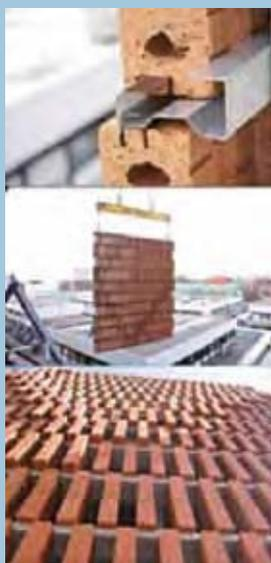
Prefabbricazione e installazione dei paramenti in laterizio di due colori.
