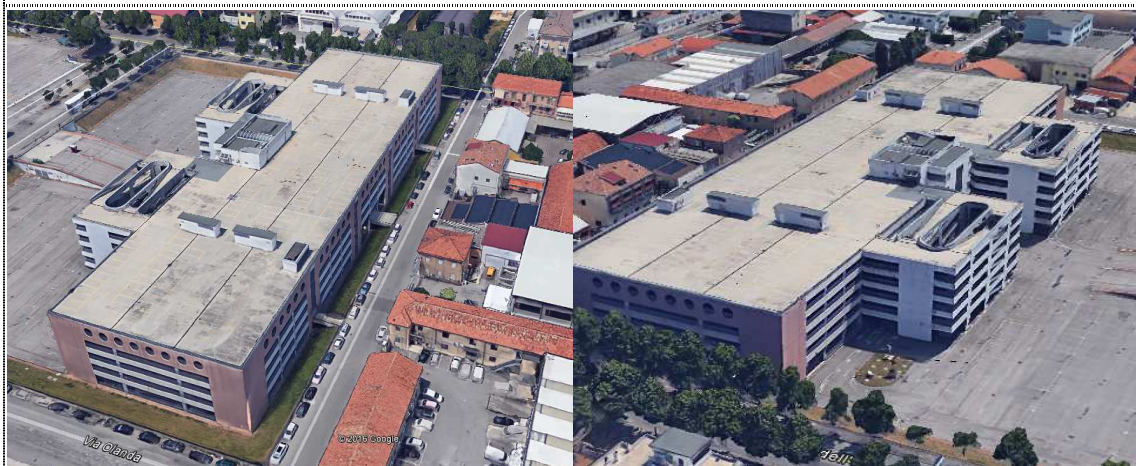
Foto n. 2 e 3: Viste aeree da Sud Est e da Nord Ovest, si noti anche qui la leggera depressione e lo scivolo
