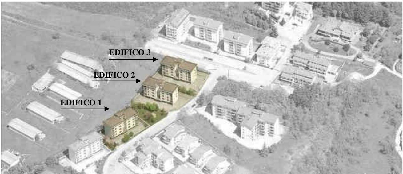
*Figura 2 I tre edifici esistenti oggetto di studio: la particolare struttura sismo-resistente e il diverso orientamento dell'edificio di Via Francia, civico 26, ha generato, rispetto agli altri, una differente risposta sismica ed un danneggiamento meno accentuato.*
