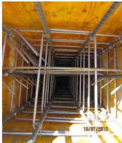
Figura 26 Particolare nodo pilastro – trave con dettaglio della staffatura composta da elementi ricavati mediante la sagomatura di un unico ferro.
