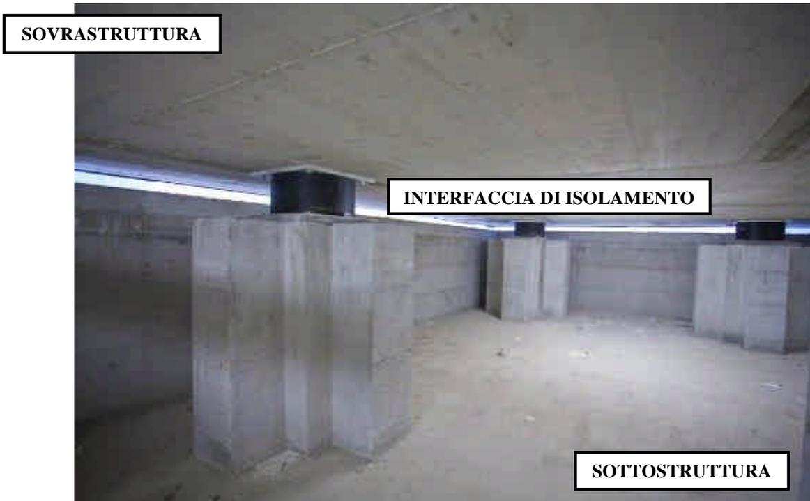
Figura 24 Interfaccia di isolamento completata.
