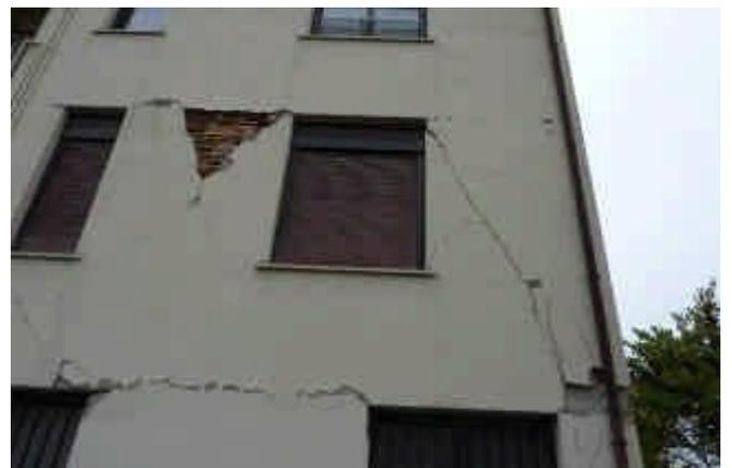
*Figura 8 Rilievo di alcune lesioni esterne dell'edificio situato in Via Francia 26. Danno rilevato meno esteso e di grado inferiore*
