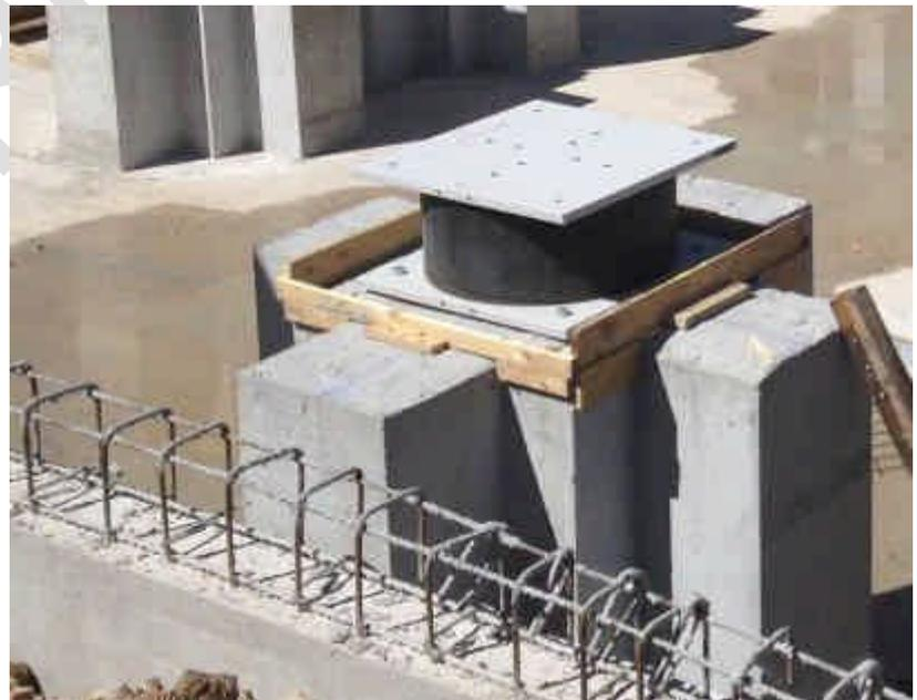
Figura 21 Casseratura in testa ai pilastri e getto di completamento al di sotto della base degli isolatori
