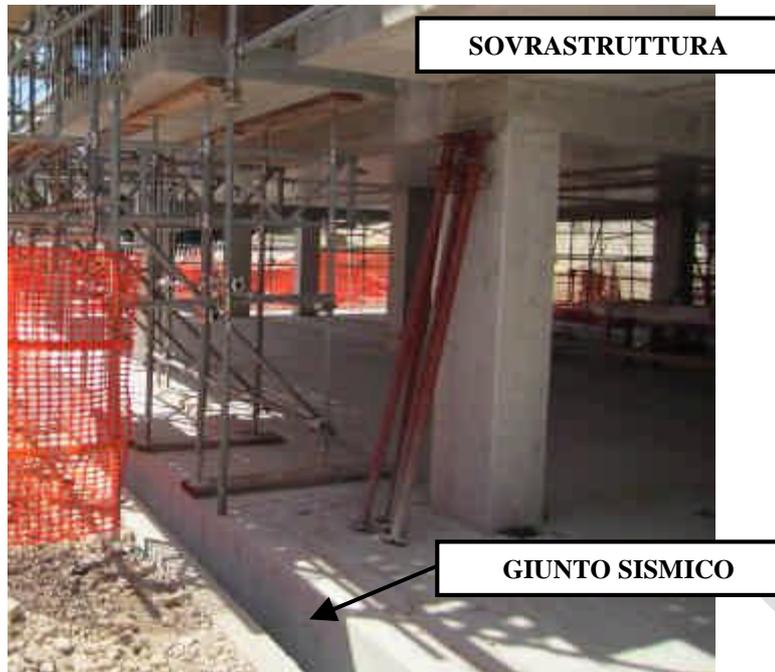
Figura 29 Montaggio del ponteggio direttamente sulla sovrastuttura
