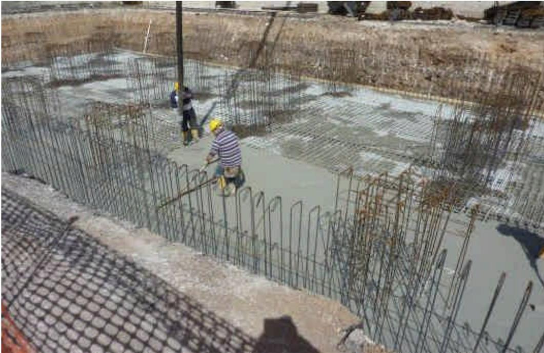
Figura 17 Realizzazione della sottostruttura: getto della platea di fondazione
