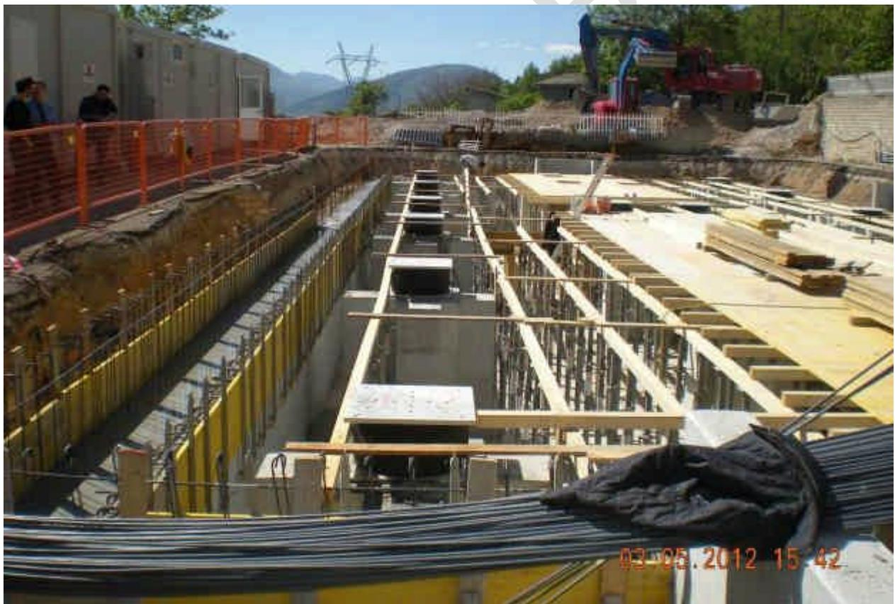
Figura 22 Posa isolatori – banchinaggio
