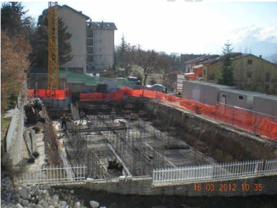
*Figura 16 Realizzazione della sottostruttura: posa armatura platea di fondazione e pilastri.*
