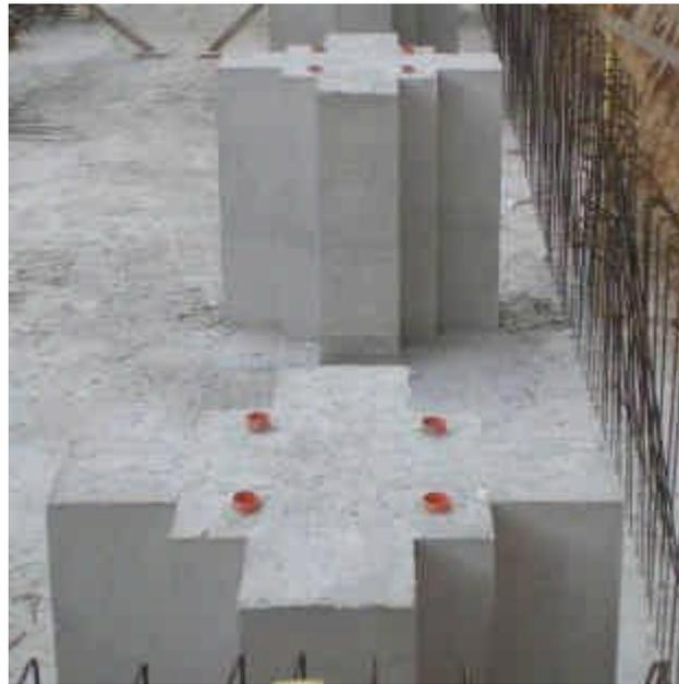
Figura 19 Pilastrini di supporto degli isolatori con predisposizione per le zanche di ancoraggio degli stessi.
