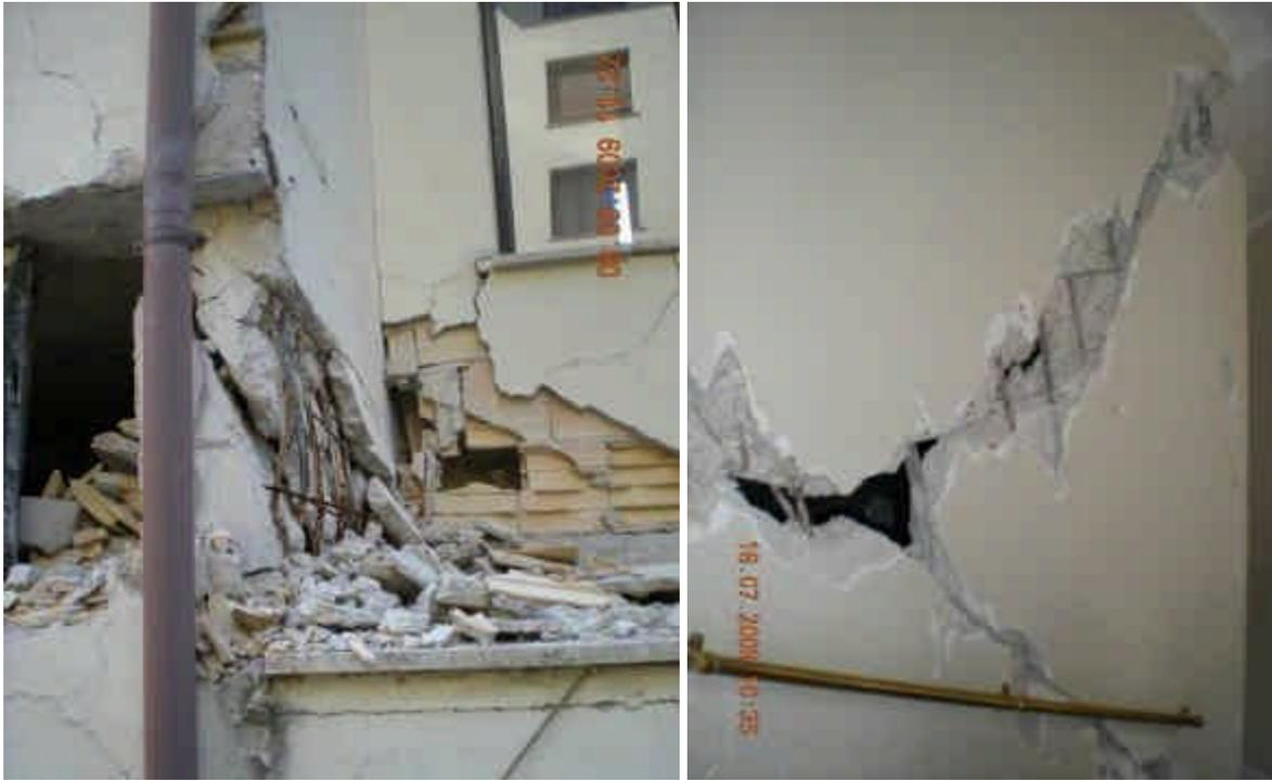
*Figura 5 Rilievo di alcune lesioni esterne dell'edificio situato in Via Francia 28 particolarmente concentrate nella zona del vano scala a piano terra.*
