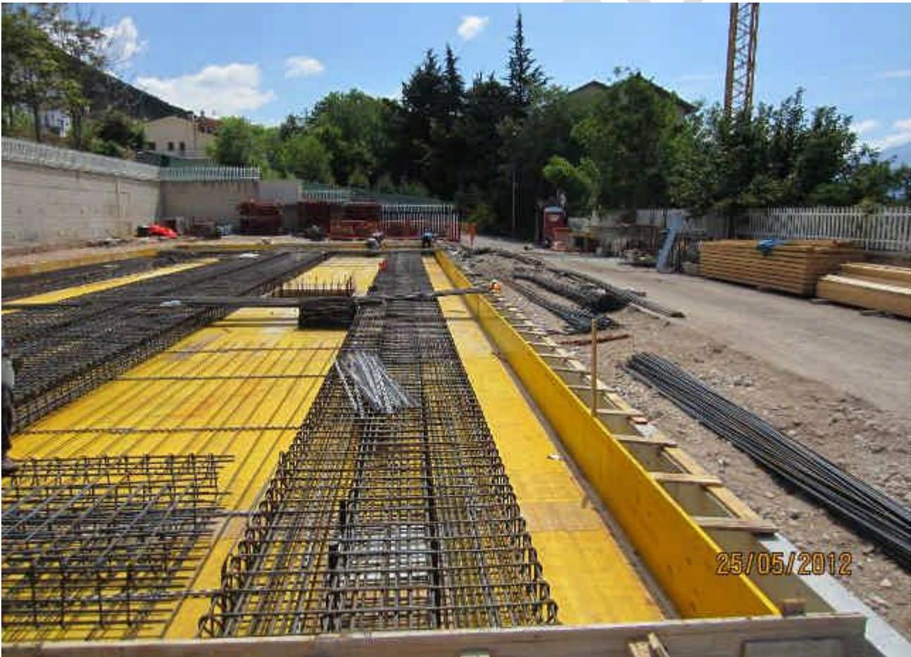
*Figura 23 Armatura della platea della sovrastruttura in corrispondenza degli isolatori*
