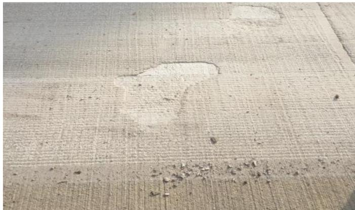
Le attrezzature consentono di eseguire, secondo le esigenze, sia interventi di semplice abrasione sia di asportazione di più alti spessori (anche 7÷8 mm per passata, in relazione alla durezza della superficie, al peso e alla potenza dell'attrezzatura e alla velocità di avanzamento). Possono eseguire scanalature, ad esempio a ridosso di giunti ammalorati, raggiungendo profondità fino a 20 mm.
