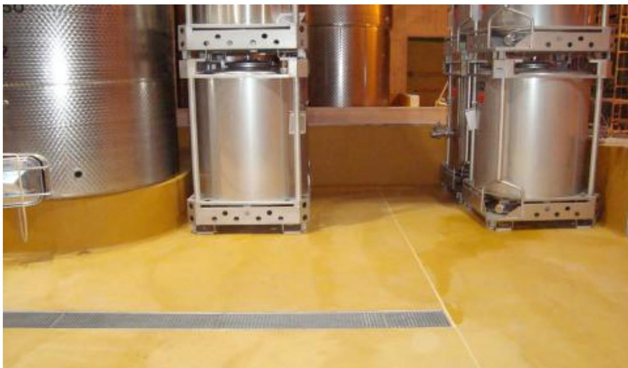
L'aggressione chimica da parte di una sostanza può avvenire in modi diversi e provocare deterioramenti più o meno gravi. Rientra nella normalità, nel caso di sostanze particolarmente aggressive, che il rivestimento subisca scolorimento o viraggi di colore, purché non si abbia un evidente calo delle prestazioni e delle resistenze generali del sistema resinoso.
