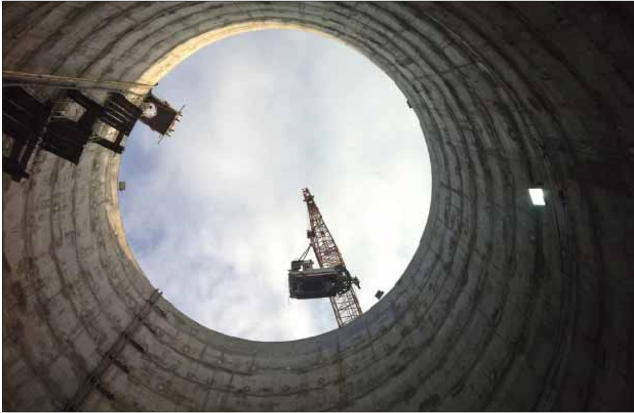
MALESIA EDILMAC Pozzo per Centrale Idroelettrica
