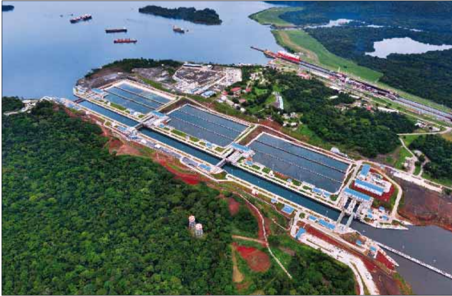
PANAMA SALINI IMPREGILO Ampliamento del Canale di Panama, terzo set di chiuse
