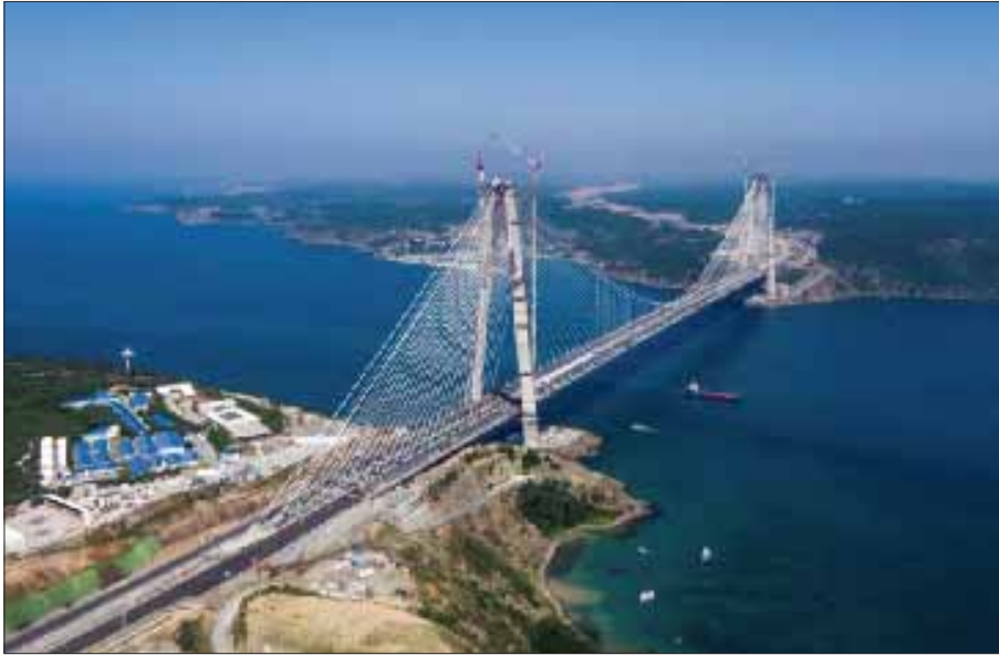
TURCHIA ASTALDI Terzo Ponte sul Bosforo
