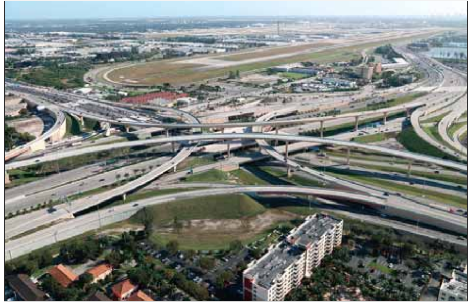
USA CONDOTTE Svincolo autostradale
