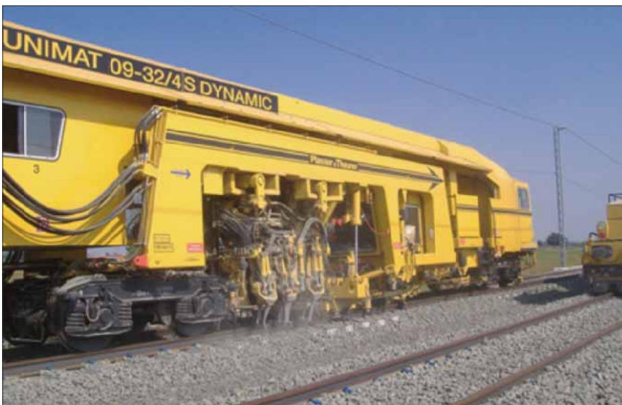
BULGARIA CLF Costruzione linea ferroviaria
