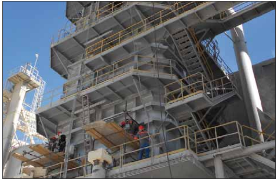
MESSICO FERRETTI INDUSTRIAL SERVICES Costruzione industriale
