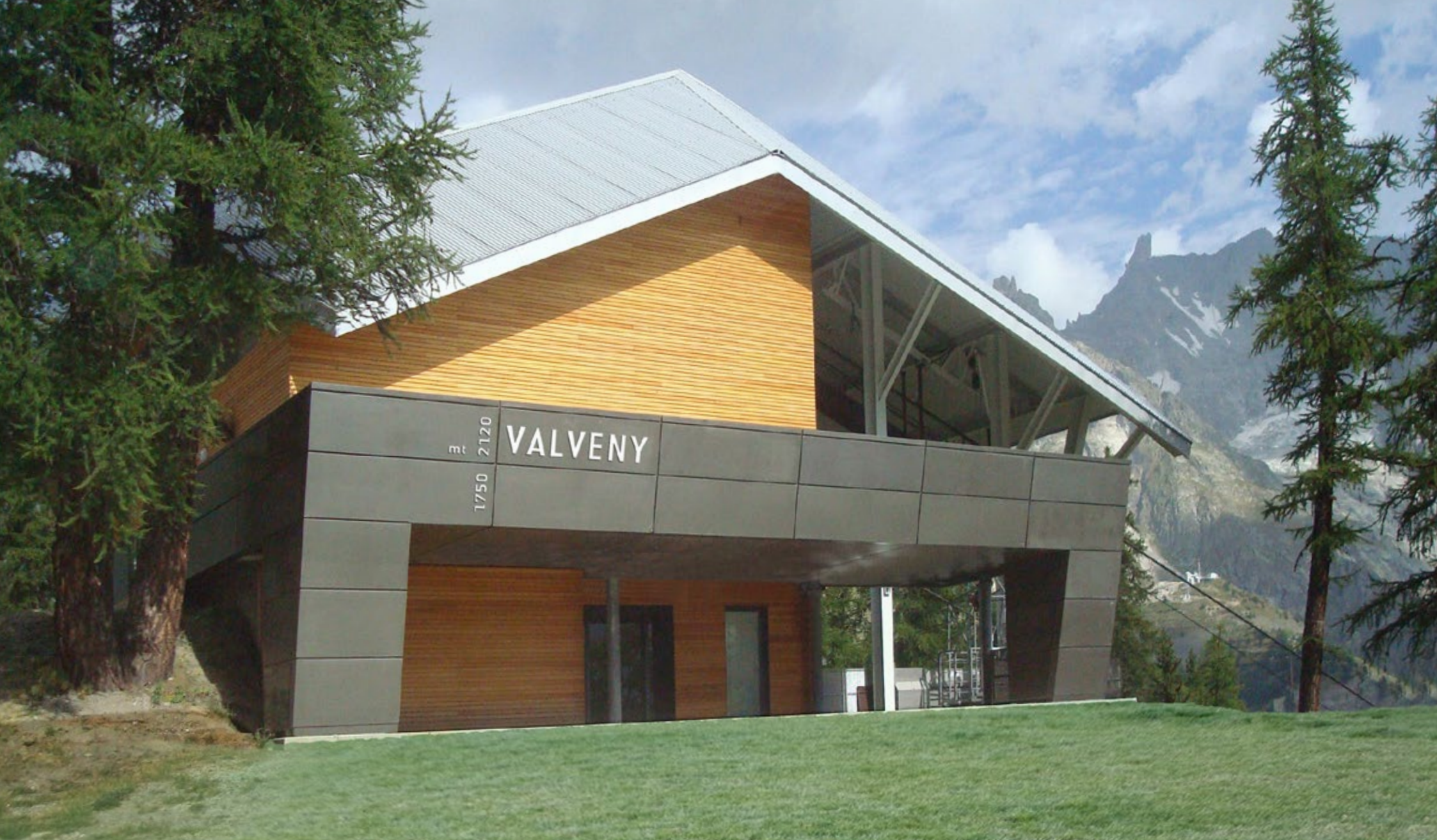
impianto : valveny monte
