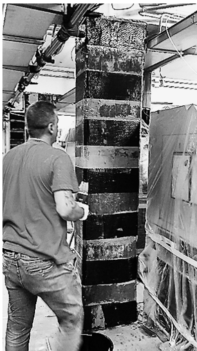
Figura 2.1. Impregnazione in situ
