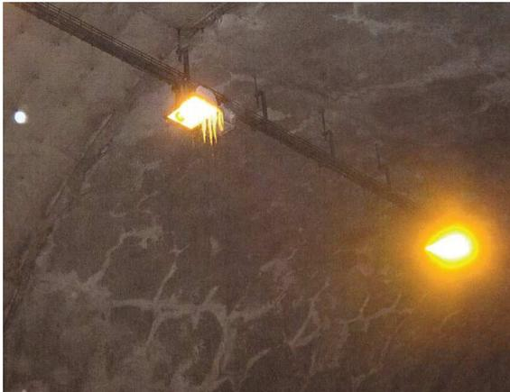
Figura 2: presenza di stalattiti sulla volta
