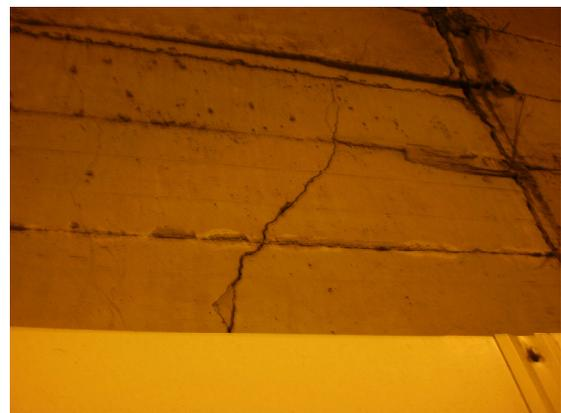
Figura 5: esempio di fessurazione rilevata nel rivestimento
