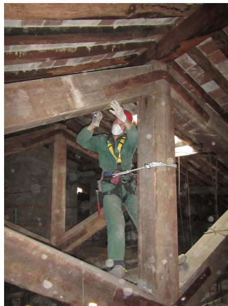
Foto 4 – Rilievo geometrico – sezione del puntone
