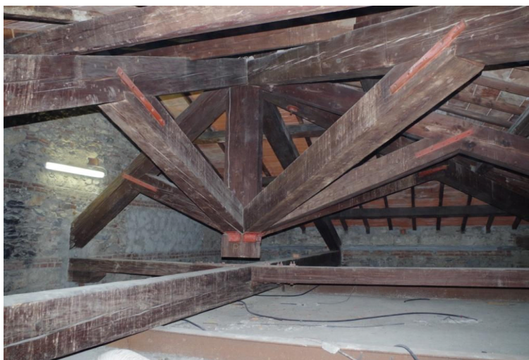
Foto 1 - Copertura a capriate, falsi puntoni, arcarecci e travicelli.
